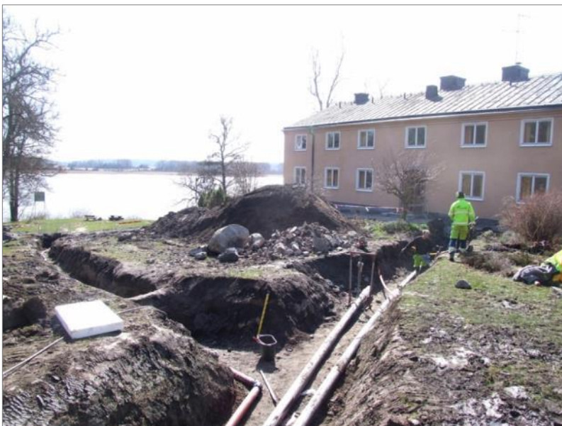
Figur 97. Schakt 14, som löpte från schakt 11 ned till Brygghuset. Foto mot S.
