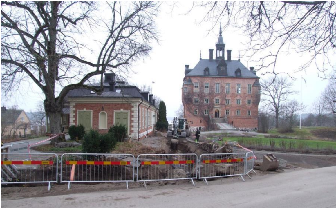
Figur 29. Schakt 6 vid Stenhusets östra gavel och längs med norra fasaden. Foto mot V.
