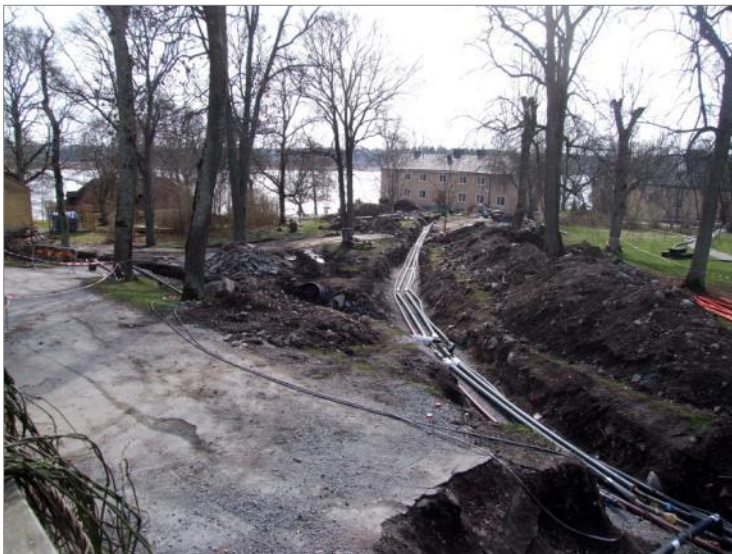
Figur 95. Översikt över schakt i parken. Foto mot SV.
