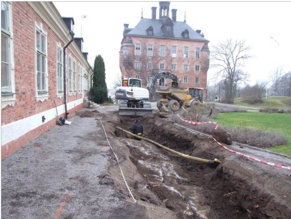
Figur 39. Översikt över del av schakt 6. Observera berg i dagen. Foto mot V.
