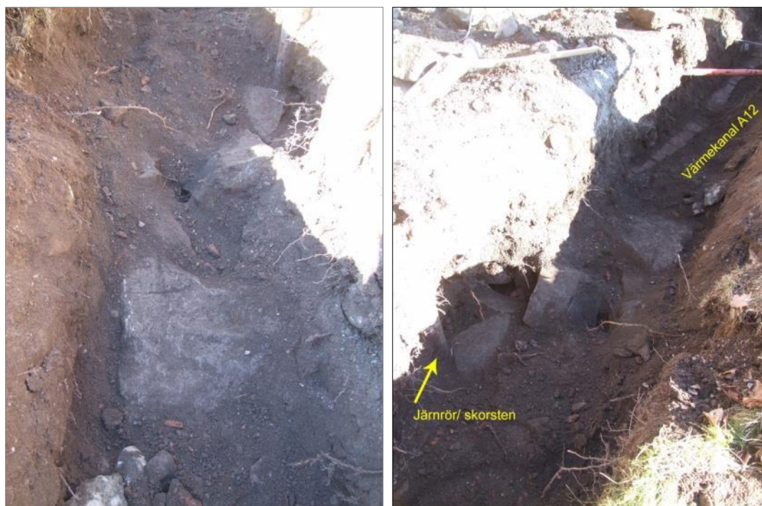
Figur 70, t.v. Ovansidan av stenkonstruktion A11 delvis frilagd. Foto mot V. Figur 71, t.h. Värmekanal A12 som leder in i konstruktion A11, troligen en nedgrävd källare med en kamin i. Ett skorstensrör sticker upp mellan stenarna. Foto mot Ö.
