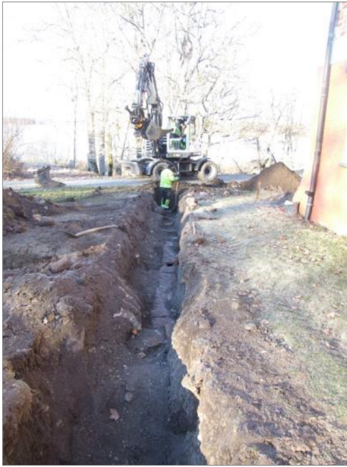
Figur 74, t.v. Värmekanal, A12 grävs fram. Foto mot V.
