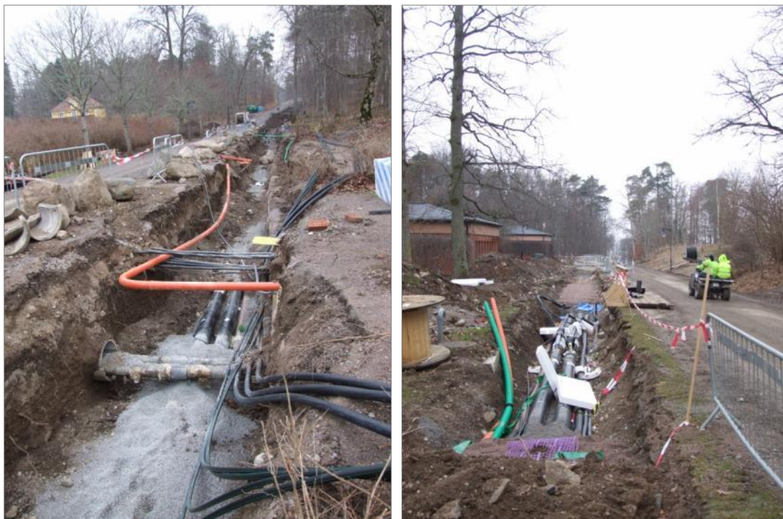
Figur 102, t.v. Schakt 15 längsmed huvudvägen som leder mellan Stenhuset och skolan. I bakgrunden skymtar Trädgårdsmästarbostaden. Foto mot Ö. Figur 103. Kopplingsgrop i schakt 15, straxt öster om skolan. Foto mot V.
