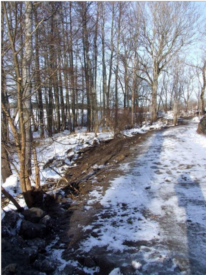
Figur 61. Gångväg mellan parkeringen och körvägen väster om Slottet. Schakt 8 igenlagt längs gångvägens västra kant. Foto mot N.
