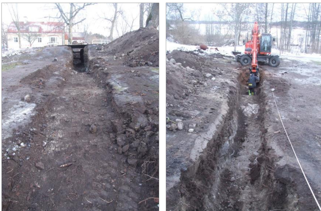
Figur 54, t.v Schakt 7 sett mot vägen där en körplåt täcker vägbanan. I schaktet anas kalkbruksputs i ett siltigt lerlager under matjorden. Foto mot Ö.
