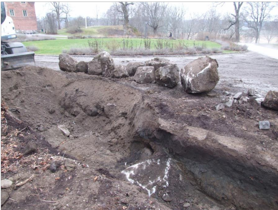
Figur 30. Schakt 6 invid avgrävt parti för rabatt. Stora stenblock fanns i den glaciala leran. I schaktbotten sticker delar av berg upp. Foto mot NV.
