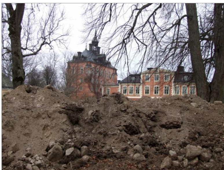
Figur 84. Stora delar av parken mellan Gymnastikhuset och Hotell And och matsalsbyggnaden grävdes upp för anläggande av nya värmeledningar och elledningar. Slottet och Stenhuset sett från schakt 11, mot NV.
