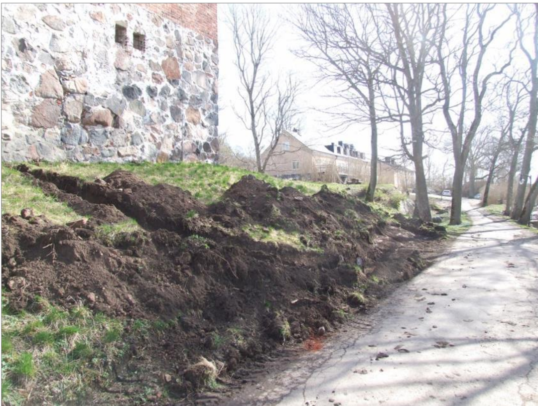
Figur 65. Elschakt 9 utmed körväg väster om Slottet. Foto mot S.
