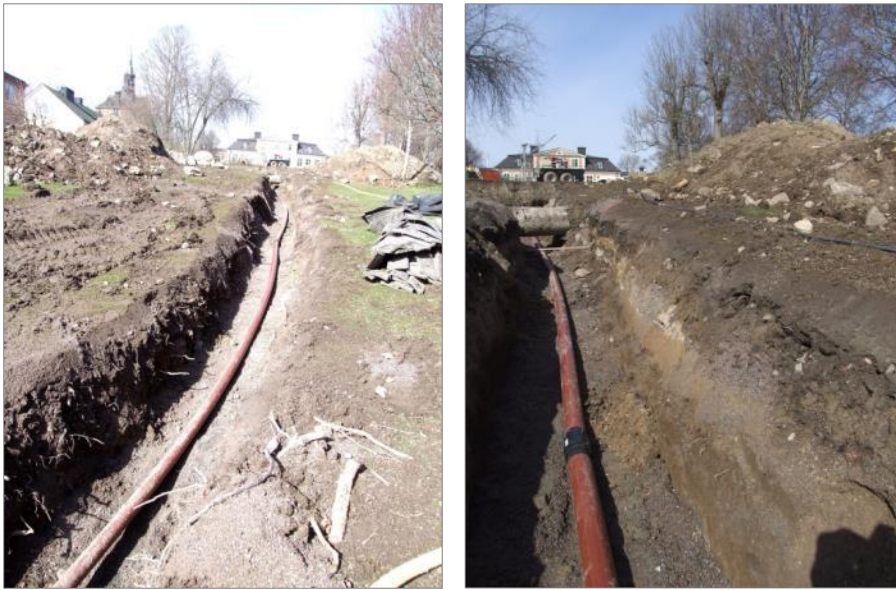
Figur 98. Schakt 14, mellan schakt 11 och Bryggghuset. Foto mot N.
