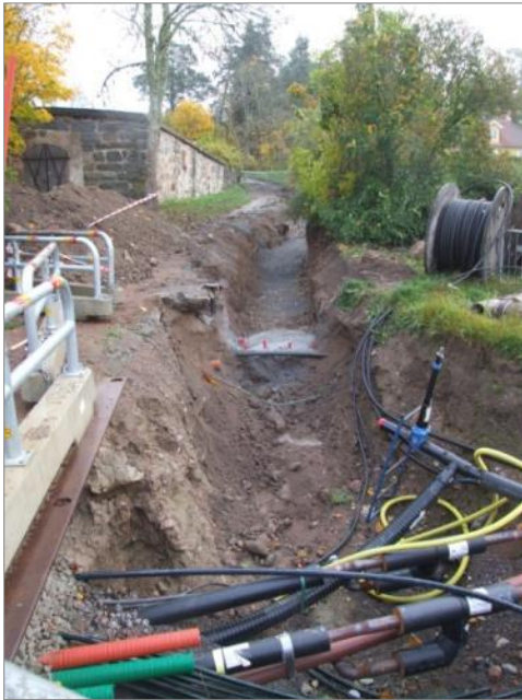
Figur 18. Schakt 1 sett mot öster. Ledningar från schakt 2 i bildens nedre del. Uppstickande berg i schaktet har sprängts bort. Foto mot V.
