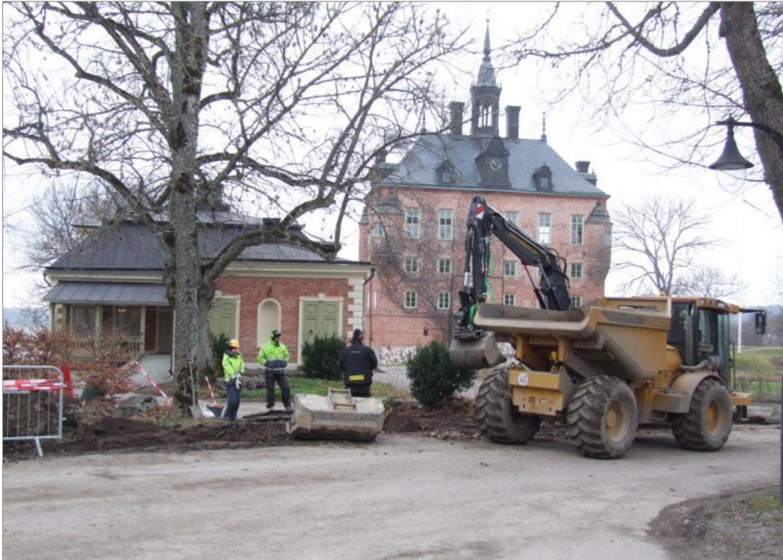
Figur 13. Schaktningsövervakning vid Stenhuset östra gavel i samband med värmeledningsarbeten i mars 2014. Foto mot V.
