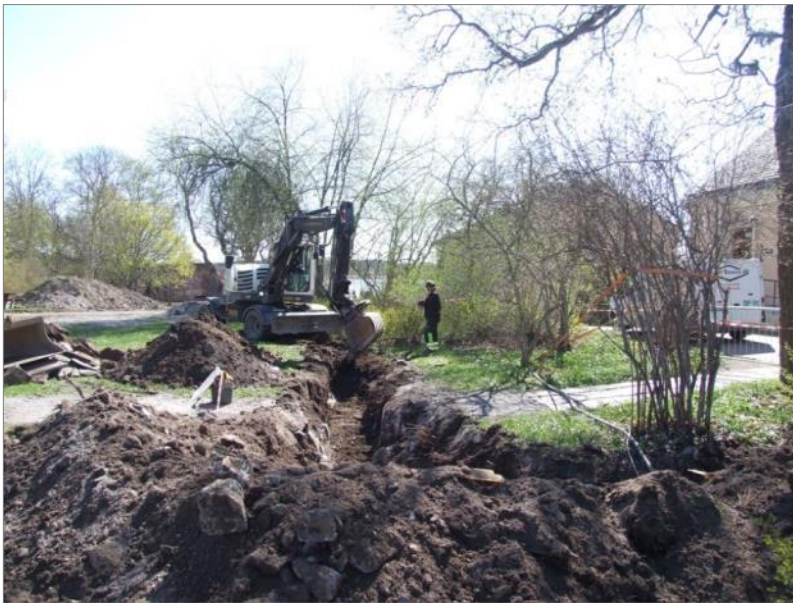
Figur 96. Schakt 13 fotat mot S.
