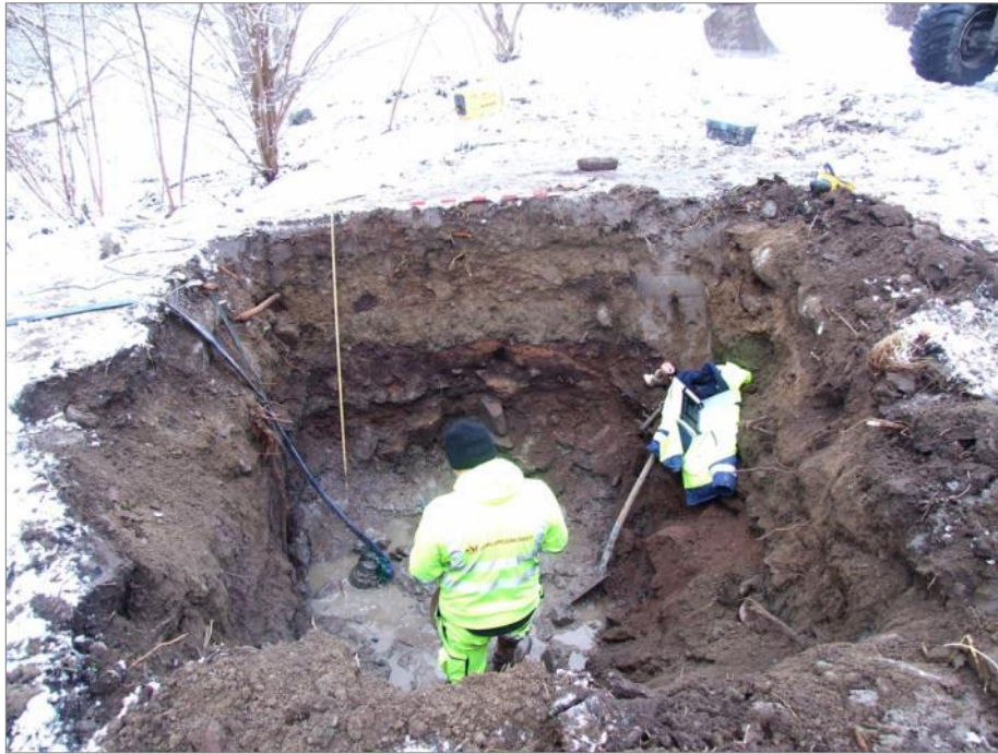
Figur 59. Robin Lucas dokumenterar sektion i pumpgroppen i schakt 7. Foto mot N.
