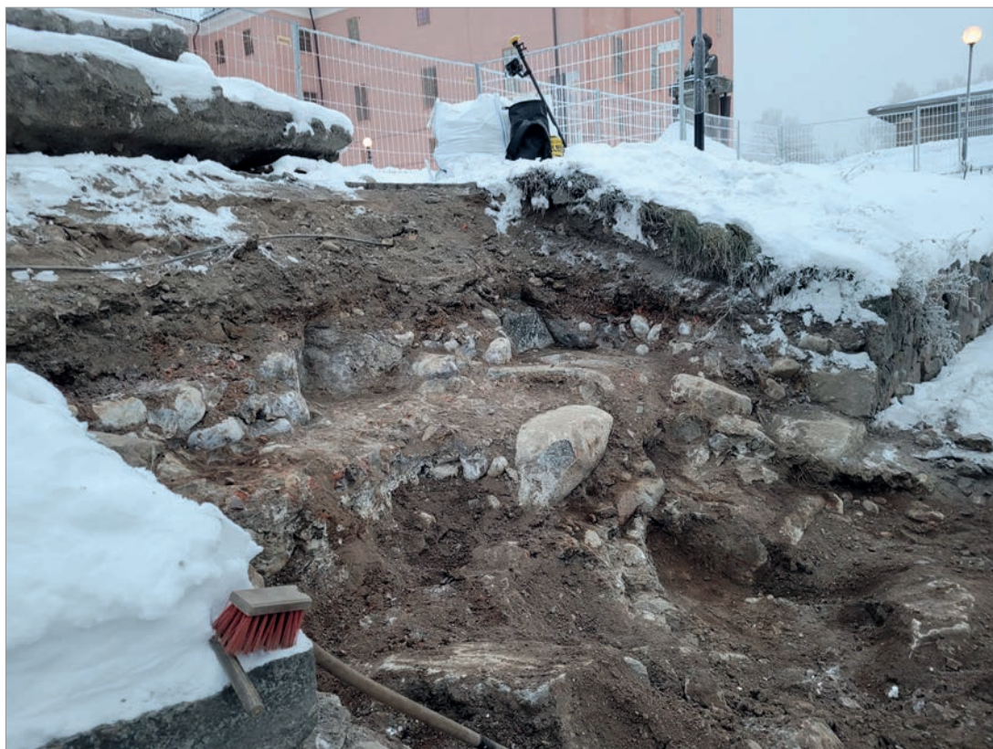
Figur 29. Delar av kurtinmuren (K.5) efter ytterligare schaktning. Foto mot sydost, Robin Lucas, Upplandsmuseet.
