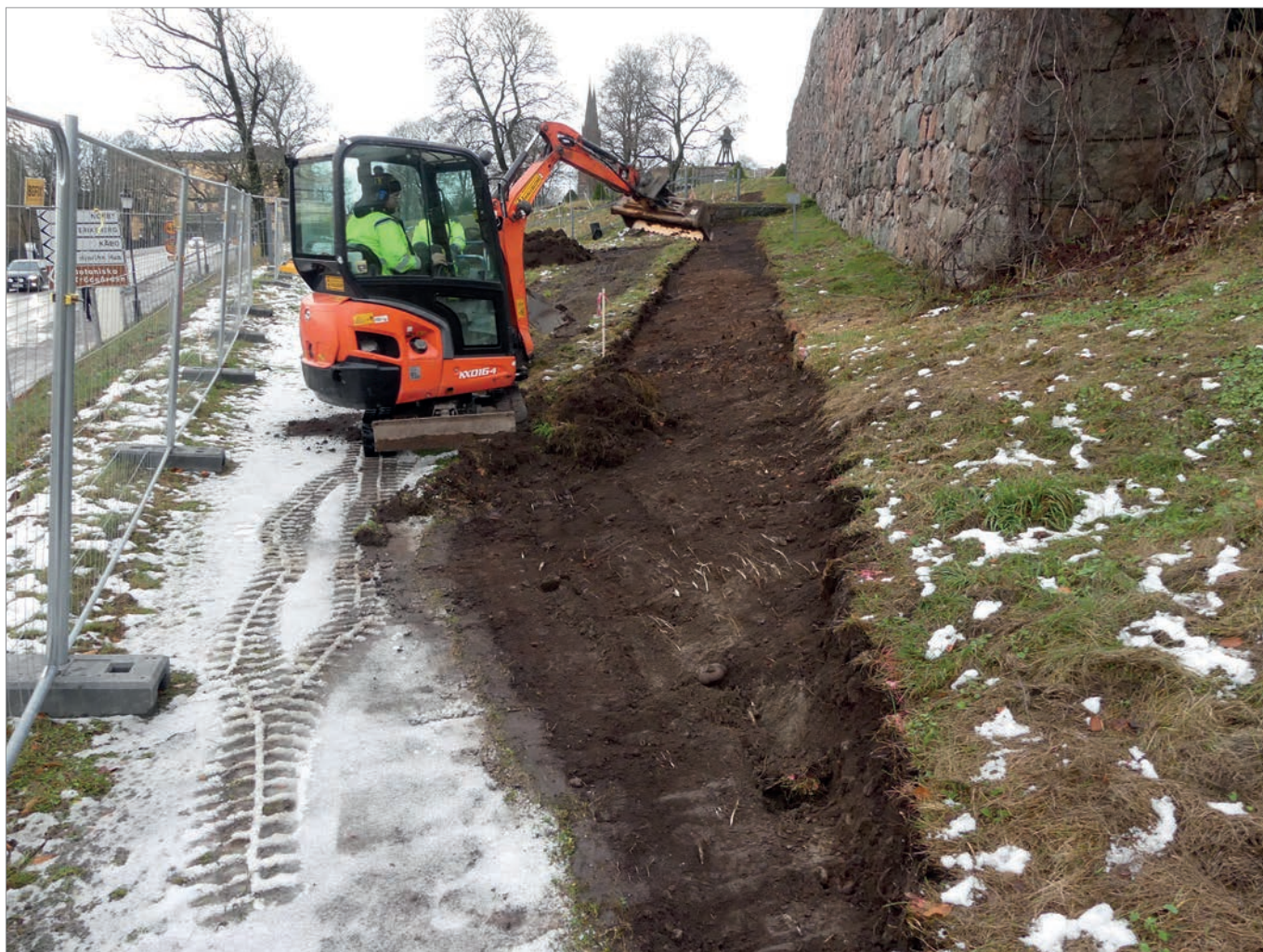
Figur 12. Schaktning för körväg (Schakt 9) intill bastion Gräsgården. Foto mot norr, Hans Göthberg.
