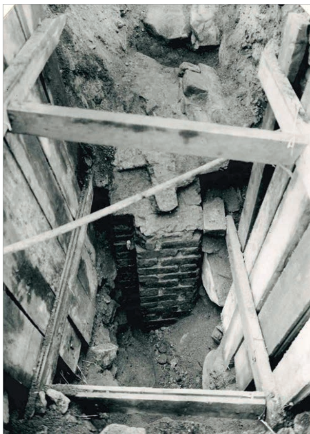
Figur 32. Dörrpost påträffad 1934. Denna konstruktion motsvarar den aktuella K.4. Notera gångjärnet i urtaget på vänster sida. Fotokopian i Upplandsmuseets arkiv är spegelvänt och har därför redigerats. Foto Karl Hulthén, Upplandsmuseets fotoarkiv.
