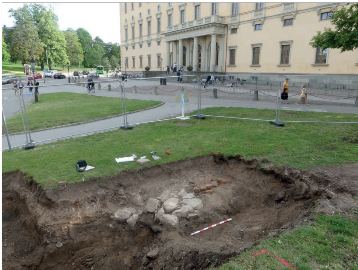
Figur 6. Vid schaktningsövervakningen 2019 påträffades rester av flera husgrunder. I bild syns stenkonstruktionen A6 med det troliga tegelgolvet A7 intill. Foto mot söder, Anna Ölund, Upplandsmuseet.
