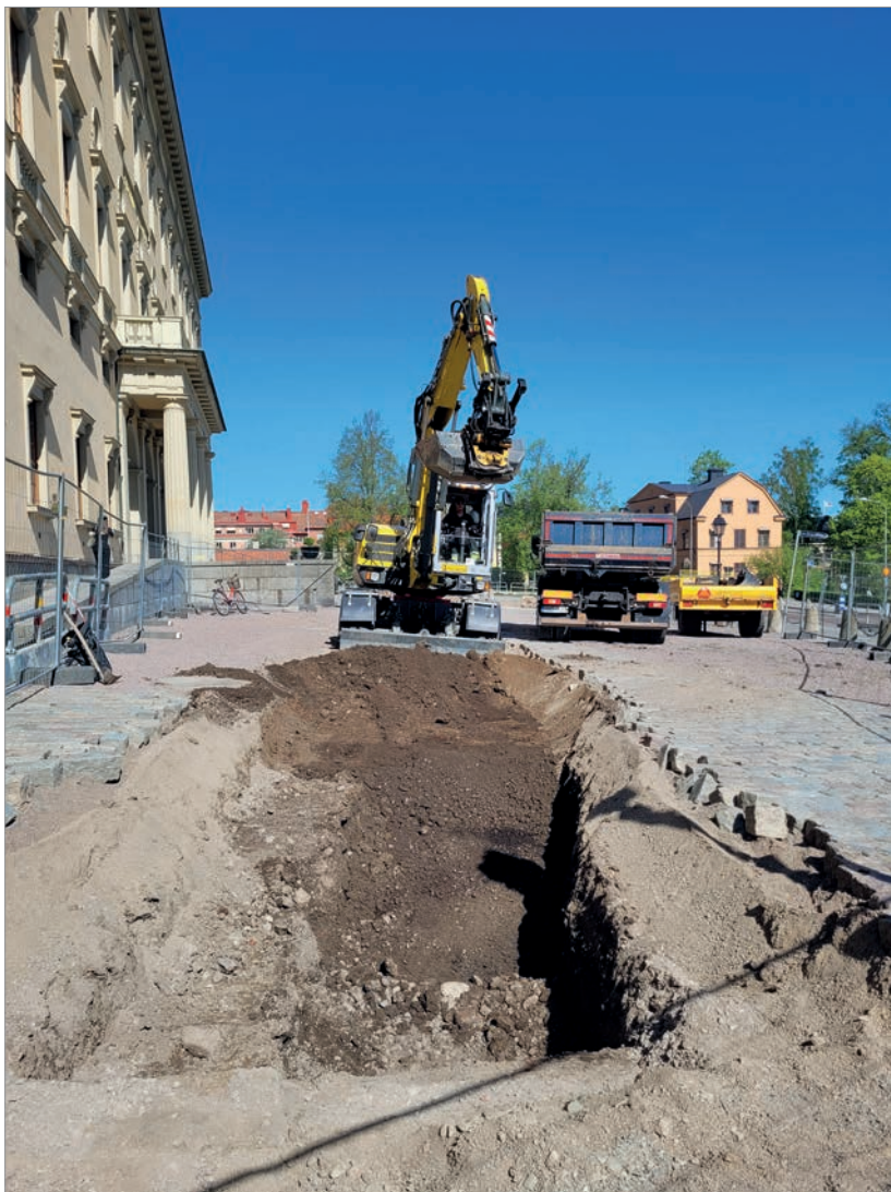
Figur 20. Påbörjad grävning av Schakt 2. Foto mot nordväst, Malin Lucas, Upplandsmuseet.
