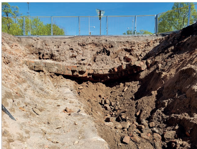
Figur 12. Valvet K.2 sett mot nordost. Notera att det på bilden redan har börjat kalva in. Till vänster i bild syns den befintliga dagvattenledningen, som alltså låg under tegelvalvet. Foto Malin Lucas, Upplandsmuseet.
