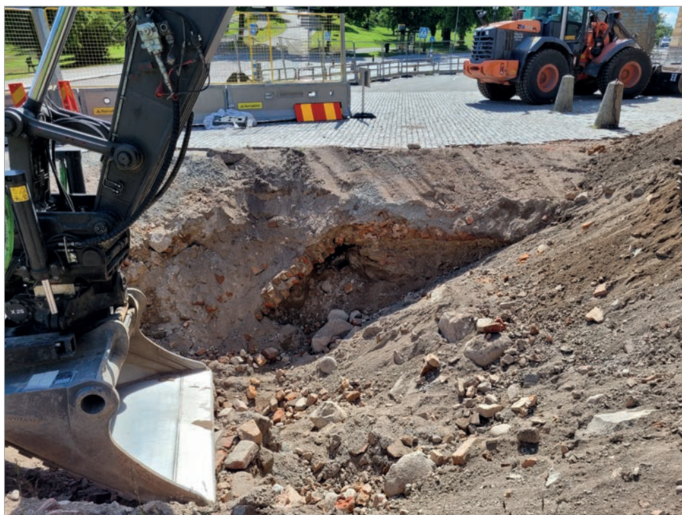
Figur 14. Tegelvalvet K.2 i den södra schaktkanten. Foto mot söder, Anna Ölund, Upplandsmuseet.
