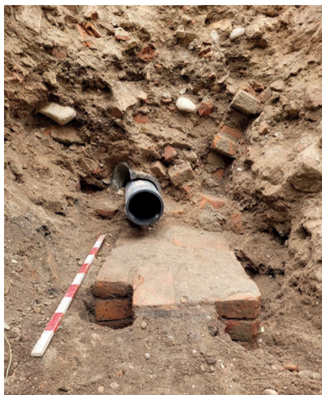
Figur 17. Dörrposten K.4. Till vänster syns urtaget för dörrbladet. Till höger kan profileringen av tegelstenarna anas. I sektionen bakom konstruktionen syns tegelvalvet K.11. Foto mot öster, Malin Lucas, Upplandsmuseet.
