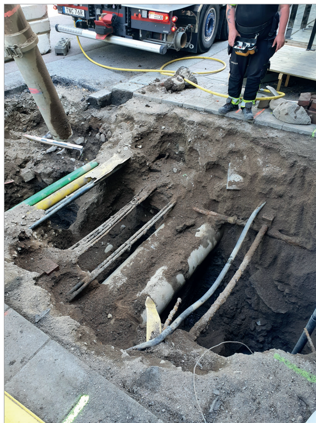
Figur 5 & 6. Schaktningen genomfördes med sugbil på grund av den stora mängd ledningsdragningar som fanns i schaktet. Foto Anna Ölund och Adam Hultberg.
