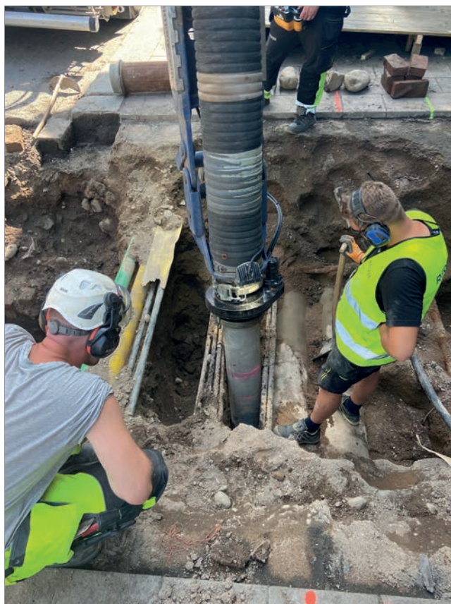
Figur 5 & 6. Schaktningen genomfördes med sugbil på grund av den stora mängd ledningsdragningar som fanns i schaktet. Foto Anna Ölund och Adam Hultberg.
