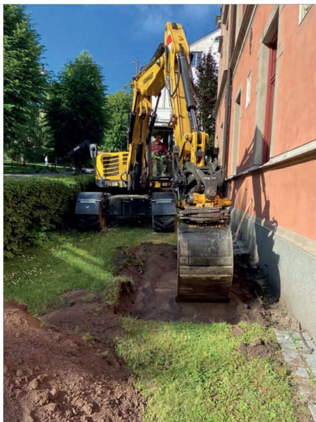
Figur 6, t.v. Markarbetet för kontroll av grundläggning påbörjas. Fotot mot väster.
