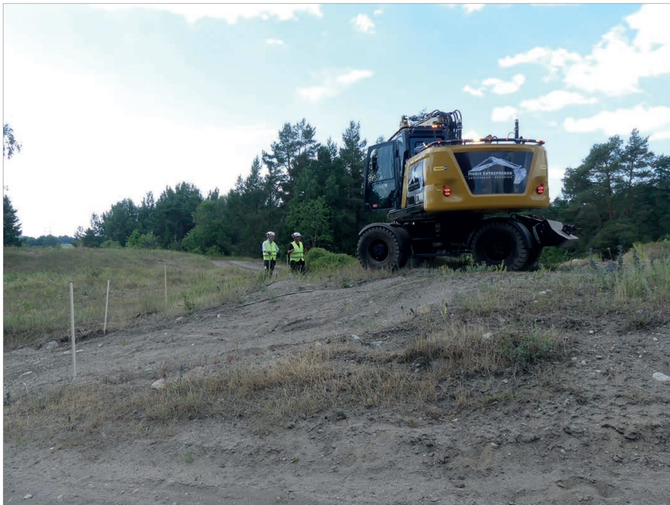
Figur 6. Schaktning har påbörjats av schakt 1. Grävmaskinen står på en upp till 0,60 meter uppfylld yta. Bakom arkeologerna syns det urtäktade området. Fotografen står i en av de djupt skurna körvägarna som låg öster och väster om schaktet. På kullen till vänster i bild ligger boplotsen L1940:955 och stensättningen L1941:6490. Foto mot sydväst: Malin Lucas.
