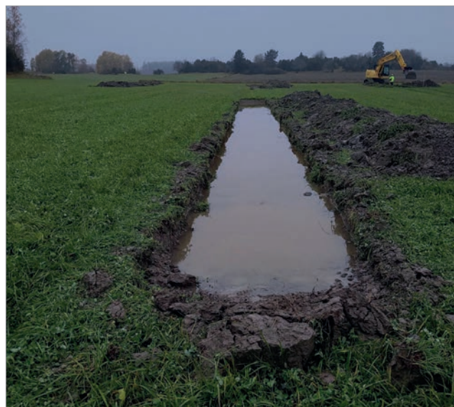
Figur 5. Det ymniga regnandet försvårade dokumentationsarbetet. Bilden visar schakt 8 med grav 3–4 (figur 6, 7) på morgonen 1/11. Foto från öster.
