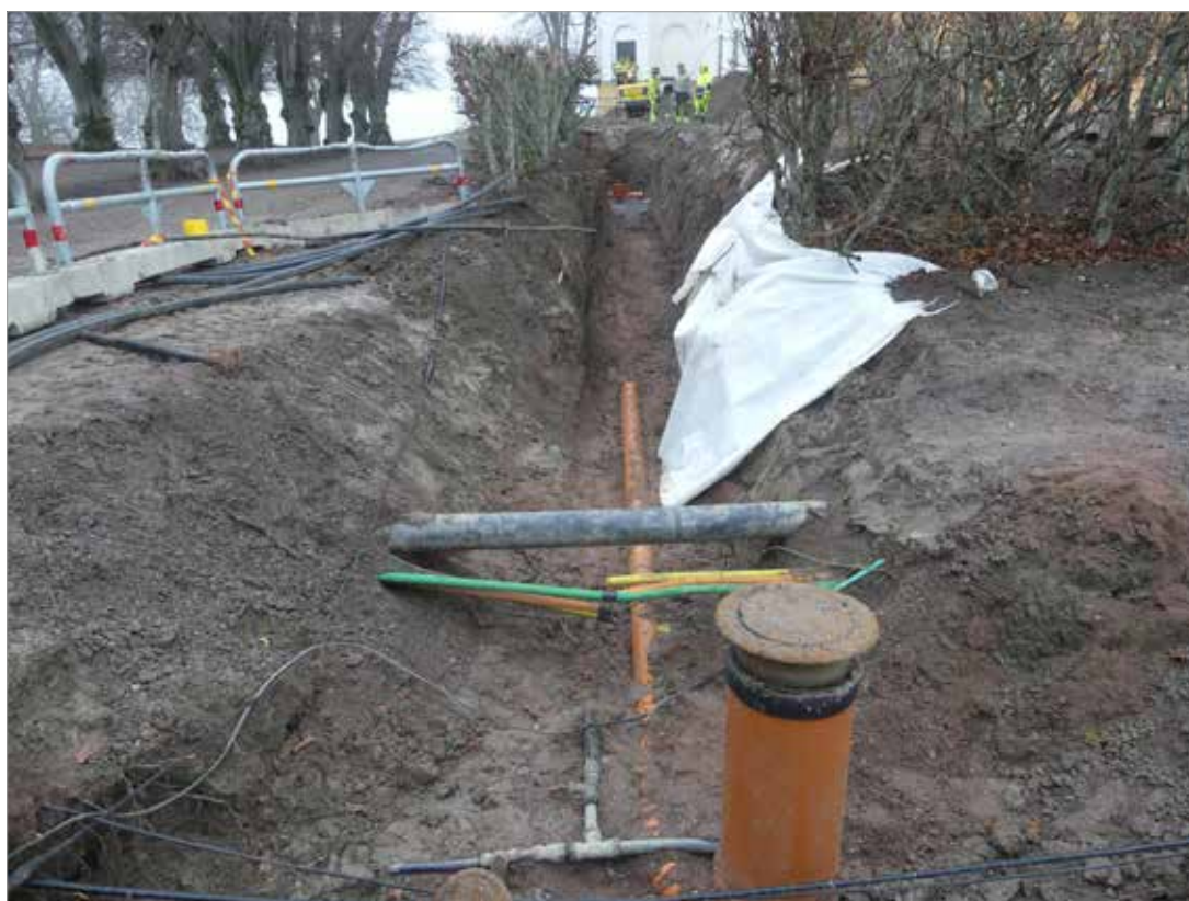
Figur 10. I anslutningen av schakt 3 till slottets nordmur finns en tydlig skillnad mellan de obearbetade fundamentstenarna och de bearbetade stenarna i sockeln strax under nuvarande markyta. Det tyder på att markytan har legat på samma nivå sedan slottet uppfördes. Foto mot söder, Hans Göthberg, Upplandsmuseet.
