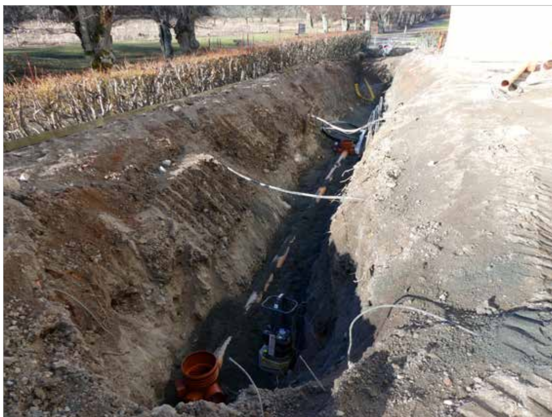
Figur 12. Schakt 5 grävdes till stor del i naturligt avsatt lera och morän. Slottets sydvästra torn till höger. Foto mot väster, Hans Göthberg, Upplandsmuseet.
