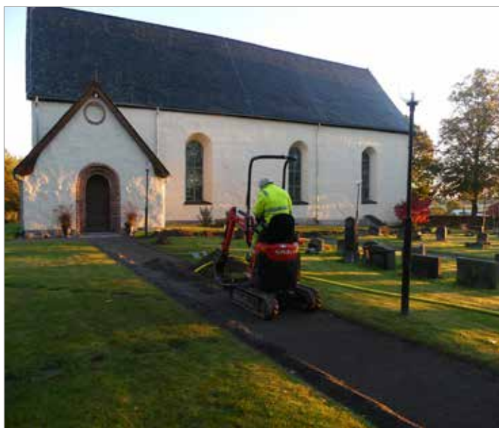
Figur 6. Schaktningsarbete. Foto mot nordöst. Ebba Drugge, Upplandsmuseet.
