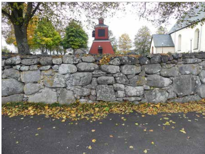
Figur 13. Brytpunkten i den östra bogårdsmuren där äldre delen av muren möter den yngre delen. Utifrån det analoga fotoarkivet på Upplandsmuseet verkar det även vara här som den påträffade delen av bogårdsmuren observerades 1977. Fotot mot väst. Ebba Drugge, Upplandsmuseet.
