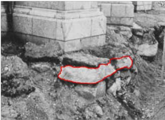
Figur 8. U Fv1976;104 (markerad) i strävpelarens fundament innan upptagandet 1975 (Gustavson 1976, s 104).
