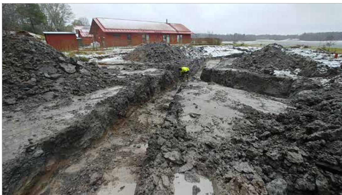
Figur 20. Arbetet försvårades på grund av väderförhållandena men även på grund av de tjocka påförda massorna som skapade djupa schakt och mycket dumpmassor. Foto mot söder, Andreas Hennius, Upplandsmuseet.
