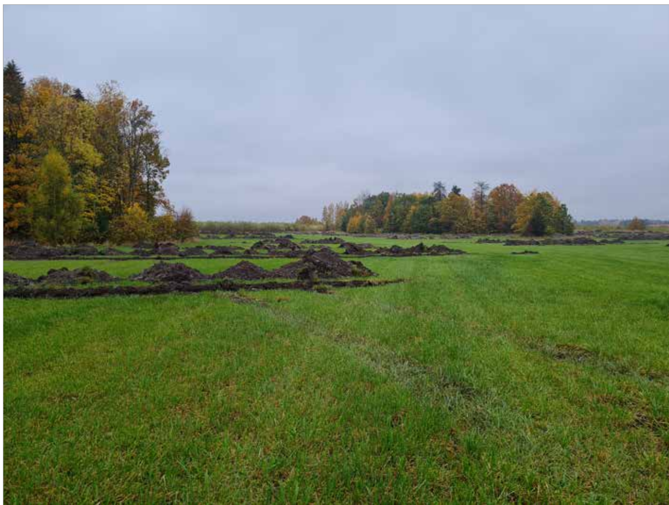
Figur 6. Grävda schakt norr om väg 635. Skogbeväxta impediment finns till vänster och höger i bild. I fonden mellan impedimenten anas energiskogen. Foto fr. SV.
