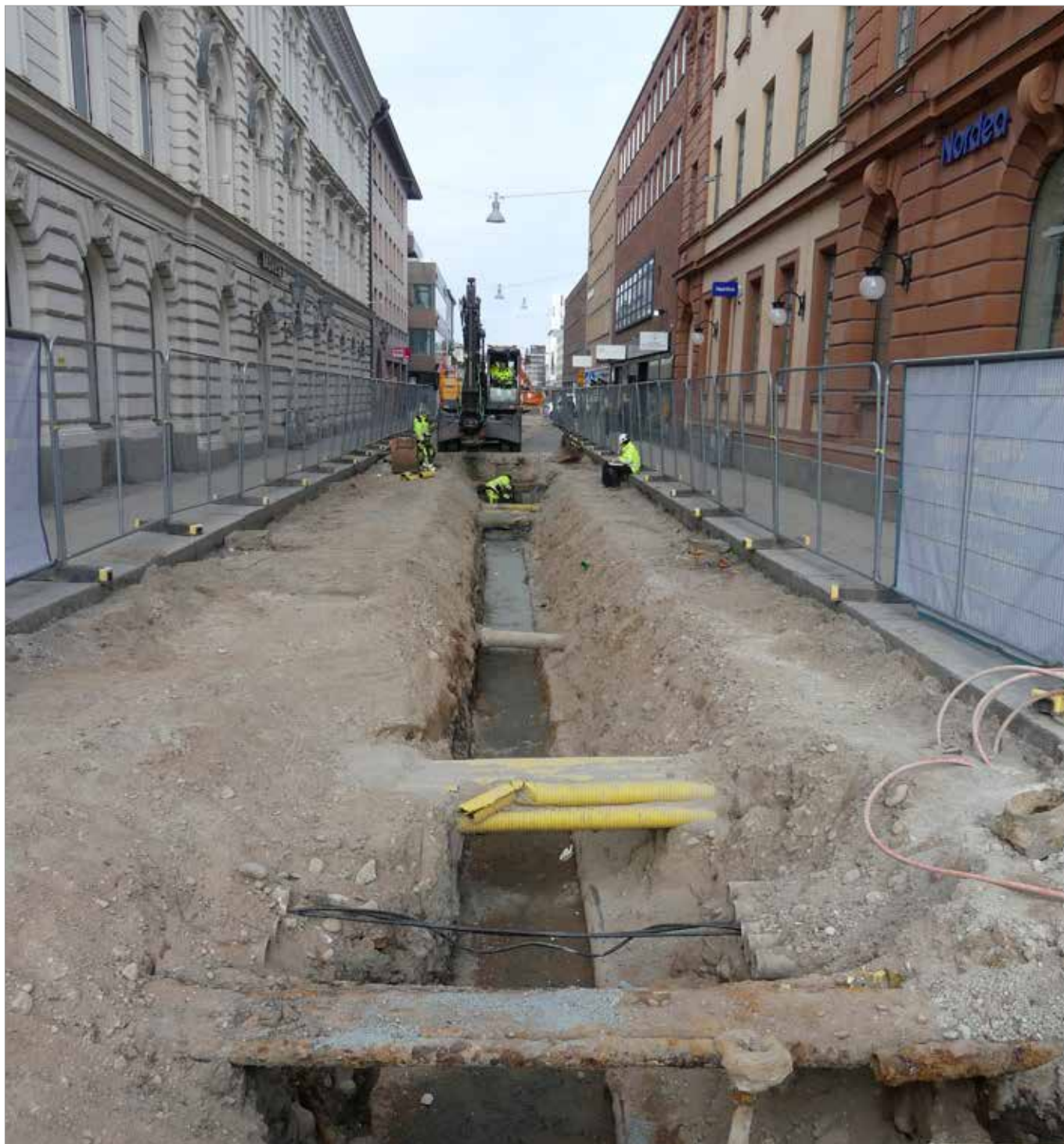
Figur 10. Schakt A grävdes centralt i Vaksalagatan mellan Stora torget och Dragarbrunnsgatan. Flertalet äldre ledningar korsade schaktet. Foto mot NÖ, Joakim Kjellberg.
