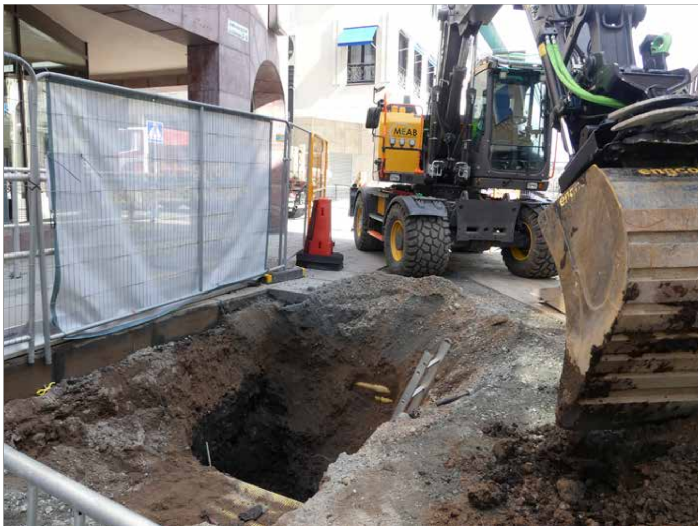
Figur 73. Schakt 1 togs upp väster om korsningen Vaksalagatan-Dragarbrunnsgatan. Foto mot NÖ, Karin Stenström.
