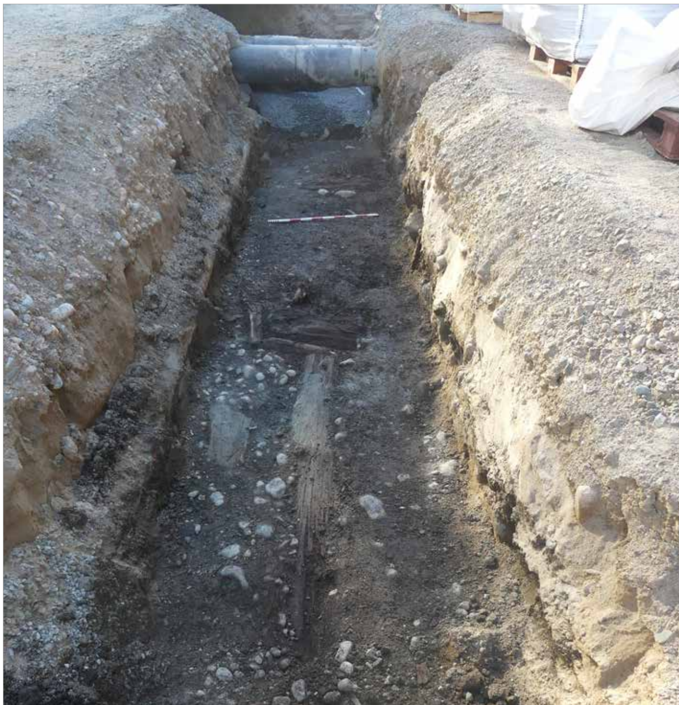
Figur 66. Den understa konstruktionsnivån innehöll framför allt olika delar av liggande trä och lager av naturligt rundade stenar i lerblandad silt (C:28 och C:30). Foto mot NÖ, Malin Lucas.
