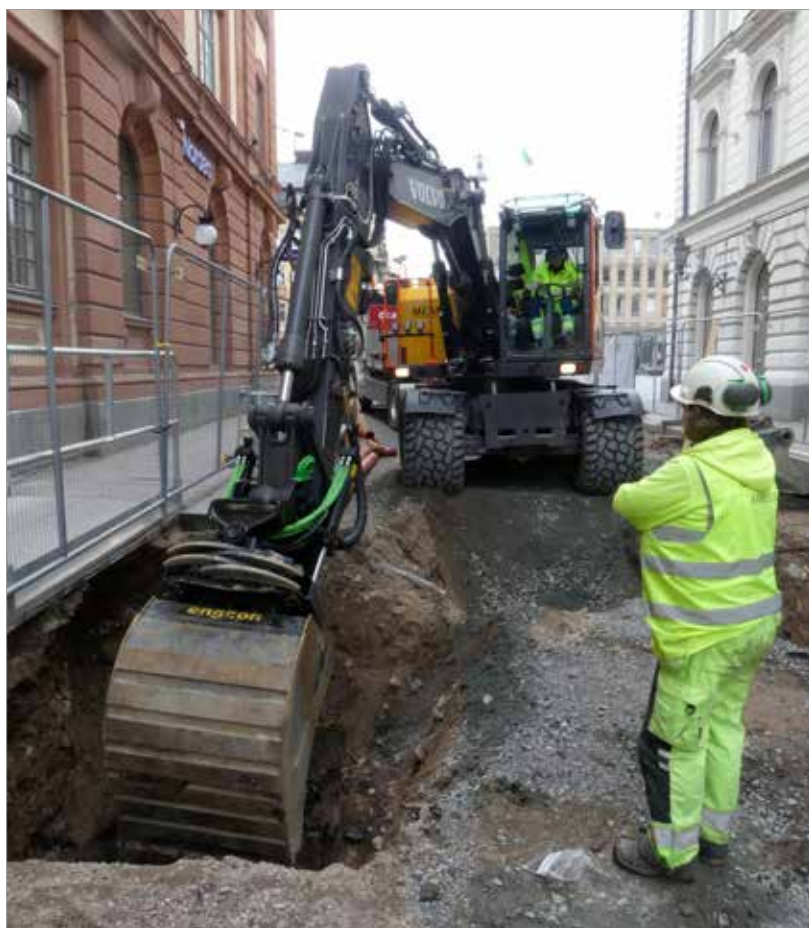
Figur 83. Malin Lucas övervakar vid grävning av schakt 3. Foto mot SV, Karin Stenström.
