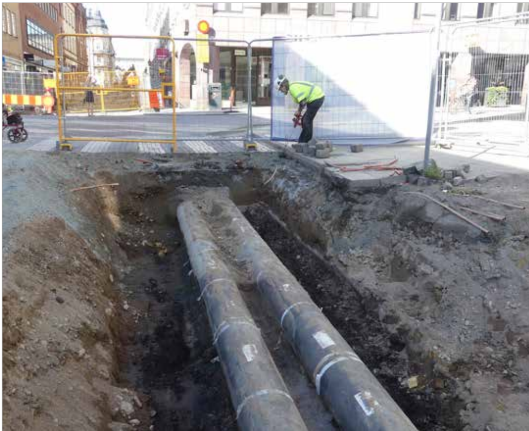
Figur 88. Schakt 5 togs upp strax nordöst om korsningen mot Dragarbrunnsgatan. I mitten av schaktet löpte två fjärrkylaledningar. Foto mot SV, Malin Lucas.
