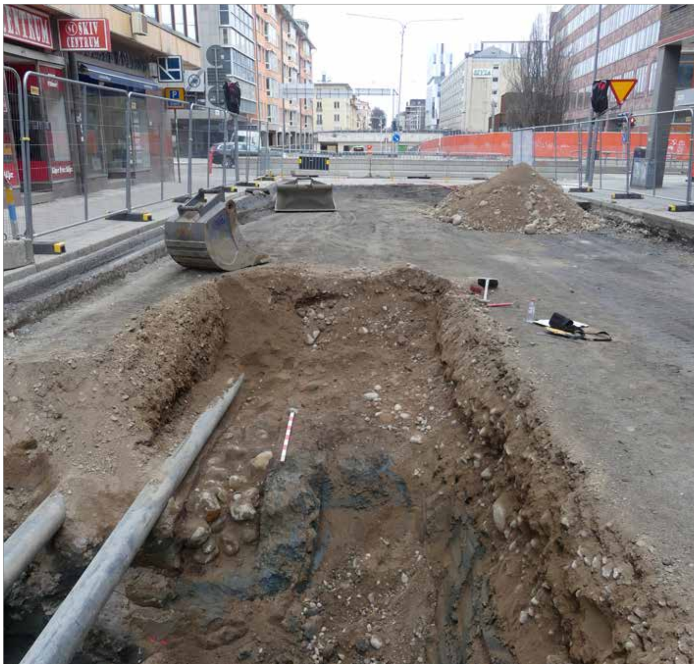
Figur 37. Den stenfyllda dräneringsrännan B:2 löpte längs med äldre ledningar och avtecknade sig tydligt mot den naturliga blåleran i schakt B. Foto mot NÖ, Joakim Kjellberg.
