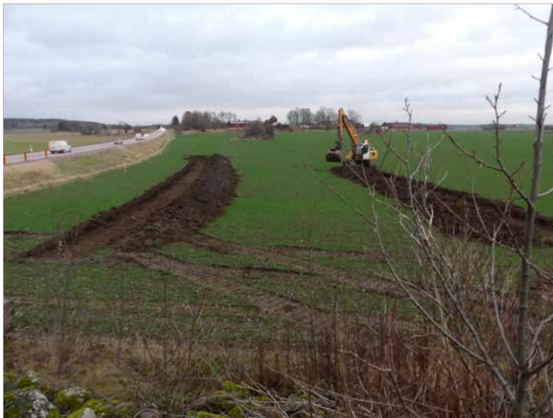
Figur 30. Inom Lokal 10 söder om vägen grävdes två schakt. I det vänstra påträffades en härd. Foto mot öster, Hans Göthberg, Upplandsmuseet.
