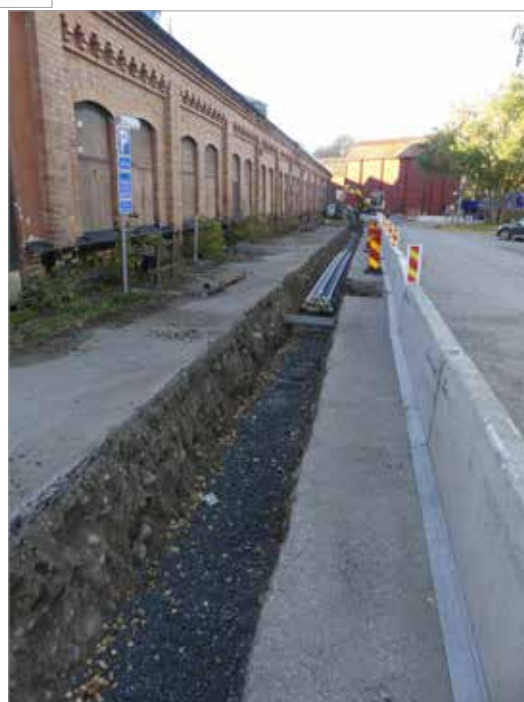
Figur 3. Schaktet i Kryddgårdsgatan vid den avslutande besiktningen. I botten, bestående av påförda fyllnadsmassor av stenblandat grus, syns ett ca 2-3 cm tjockt utlagt gruslager. Foto: Joakim Kjellberg, Upplandsmuseet.
