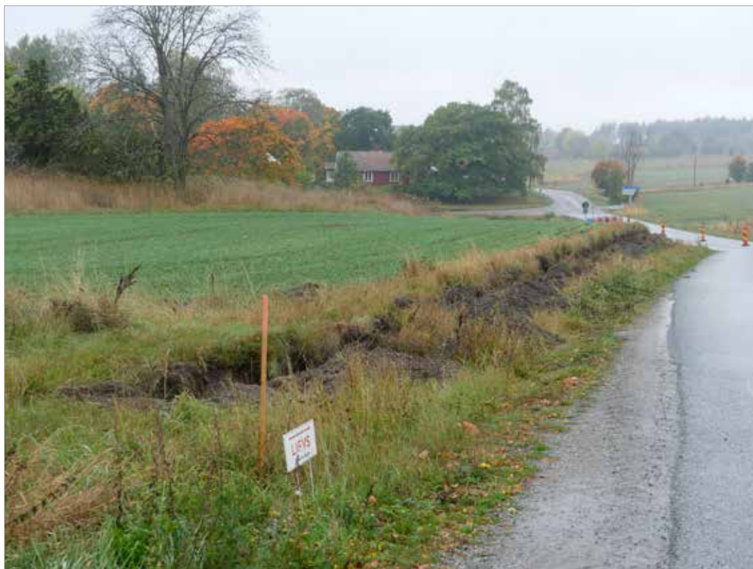
Figur 17. Schakt 200003 grävdes i bakslänt av ett vägdike på en platå i sluttning. Foto mot väster.
