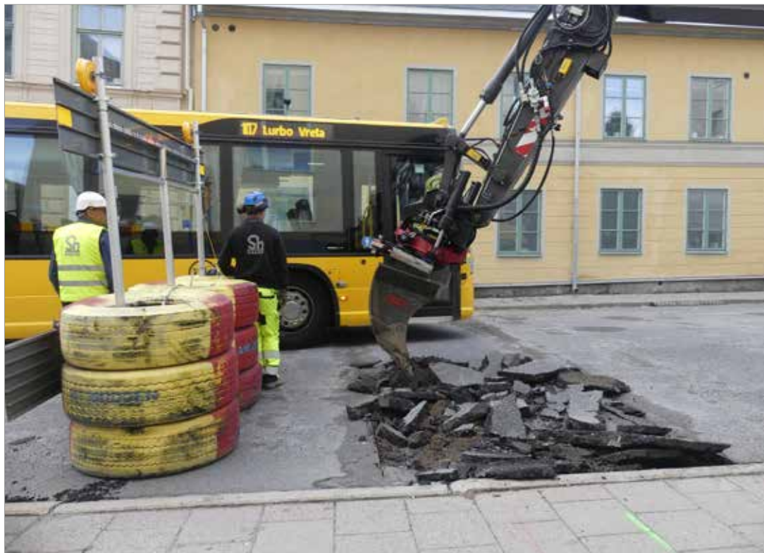
Figur 13. Asfalten avlägsnas i schakt 2, Bäverns gränd. Foto mot S, Malin Lucas.
