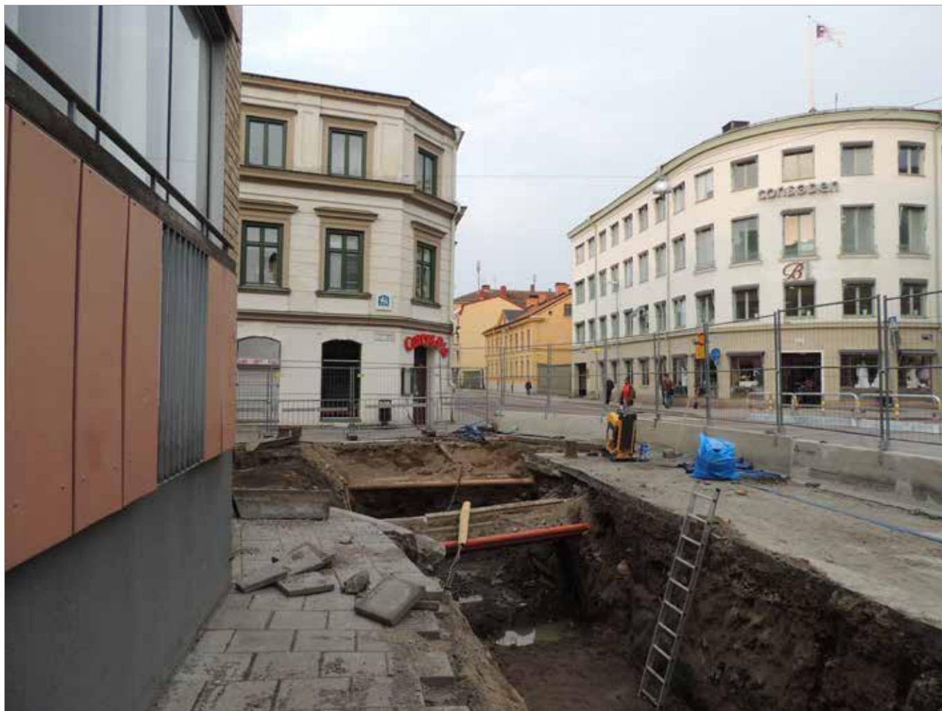
Figur 20. Schakt 4 i korsningen Kungsängsgatan-Bäverns gränd. Foto mot V, Malin Lucas.
