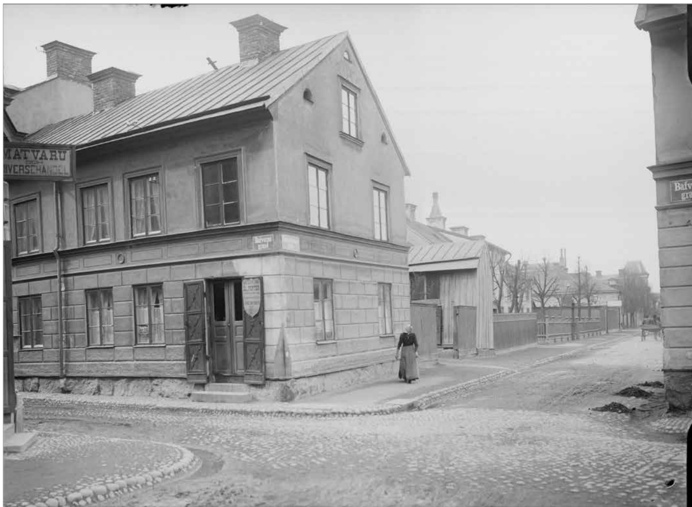
Figur 16. I hörnet av Bäverns gränd och Dragarbrunnsgatan fanns i början av 1900-talet det avbildade huset. Möjligen kan rustbädden A2 höra till denna byggnad. Foto Alfred Dahlgren, Upplandsmuseet
