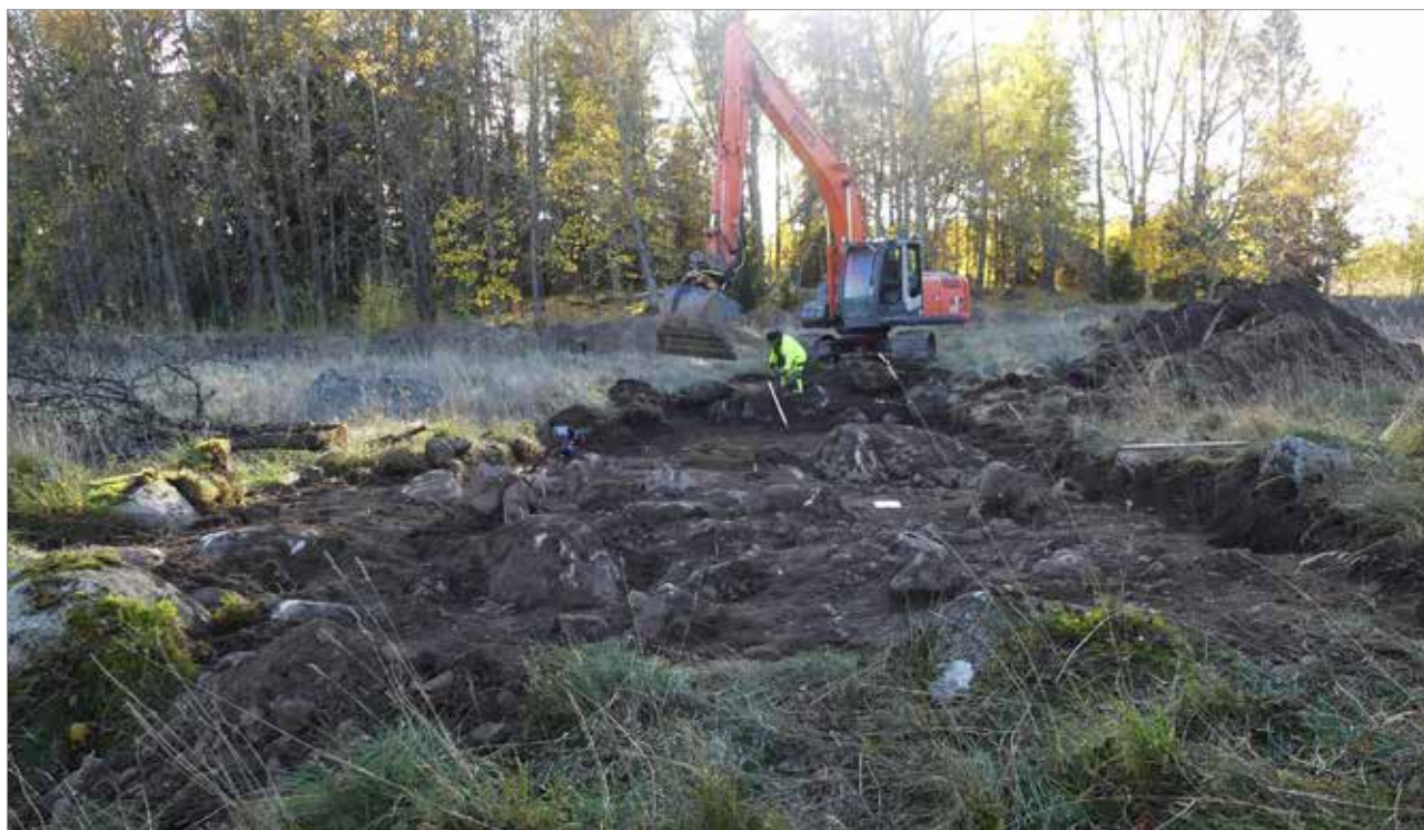
Figur 8. Grävning och rensning i schakt 2888. Foto fr. Ö.
