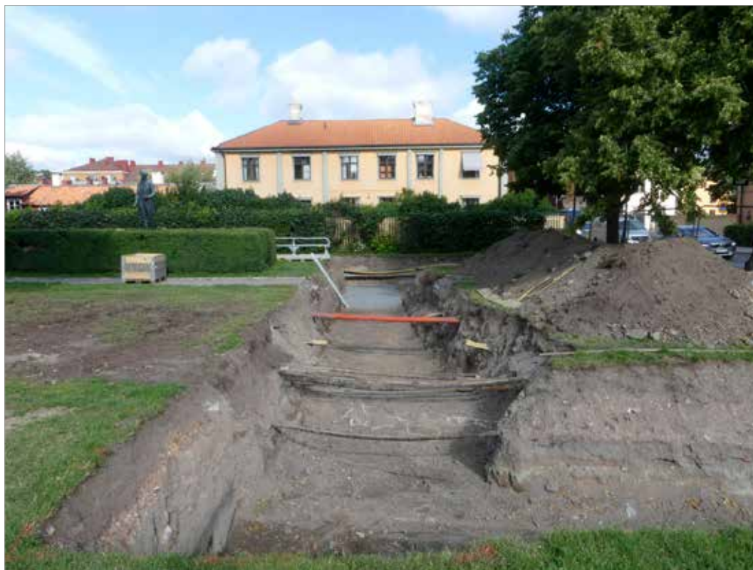
Figur 46. Schakt D grävdes parallellt med Övre Slottsgatan. Schaktet genomkorsades av flera äldre ledningar och samma fjärrvärmekulvert som också korsat schakt A, B, E och F. I bakgrundens syns Geijersgårdens huvudbyggnad. Foto mot NV.
