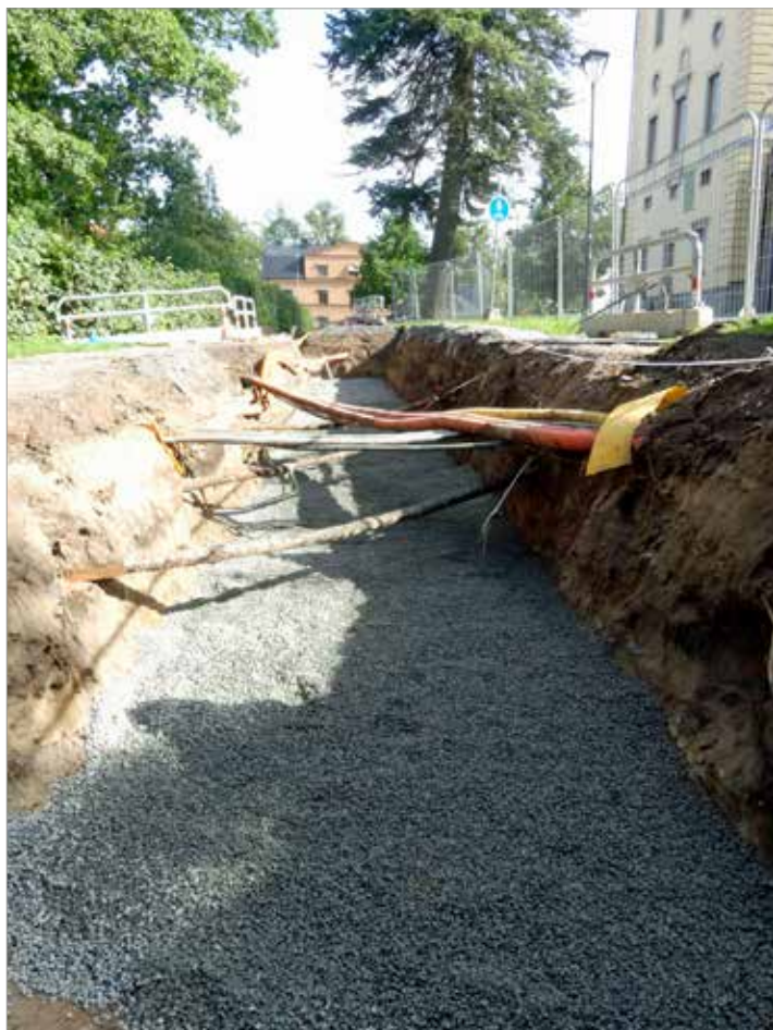
Figur 17. Sydvästra delen av schakt B som genomkorsades av flertalet ledningar. Foto mot NÖ.
