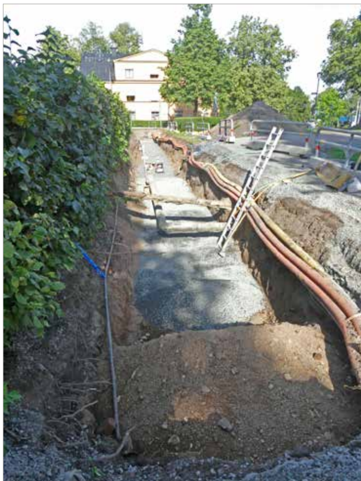
Figur 16. Nordöstra delen av schakt B med flertalet ledningar. Foto mot NÖ.
