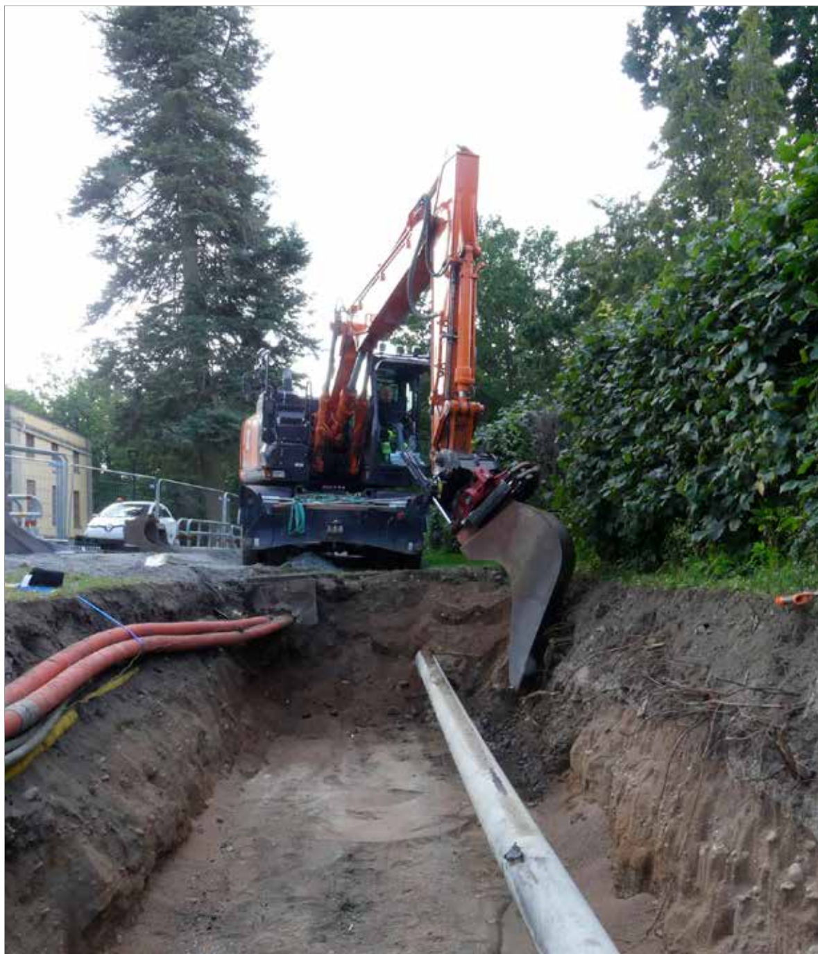
Figur 11. Pågående schaktning längs Geijersgårdens sydöstra tomtgräns. Foto mot SV.
