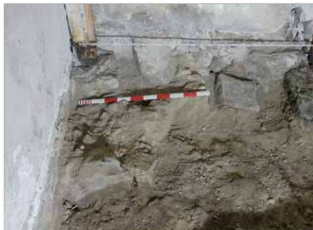
Figur 14. Valvpelarfundament A6 i långhusets NV hörn. Fundamentet har delvis använts som underlag för pelarna som håller upp orgelläktaren. Foto mot N.
