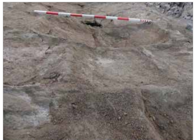
Figur 22, ett golvunderlag i form av bruk med avtryck av golvplattor och med en tydlig sättning i mitten. Foto mot V.
