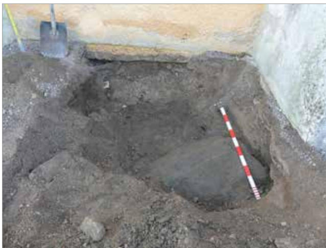
Figur 28. Del av fundamentering till tornet. Foto mot SV.
