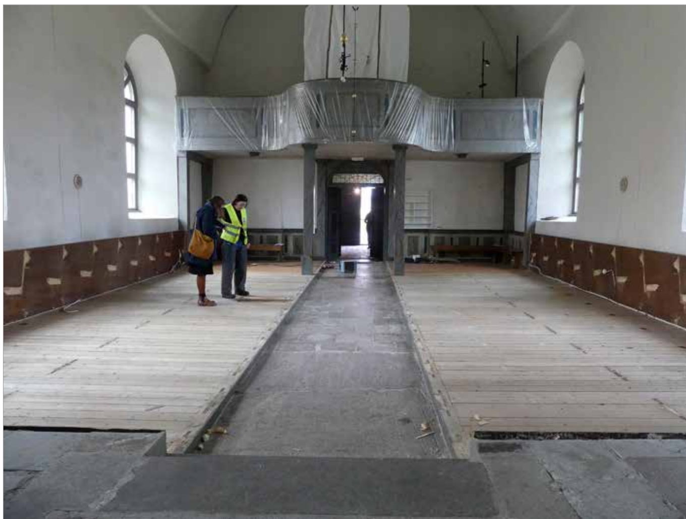
Figur 5. Långhuset efter att bänkarna plockats bort men innan golvet avlägsnats.
