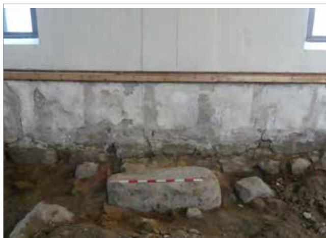
Figur 13. Valvpelarfundament, A5. Foto mot N.
