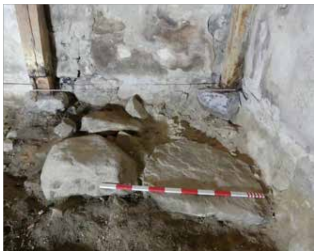
Figur 16. Valvpelarfundament, A8, i långhusets sydvästra hörn. Foto mot S.
