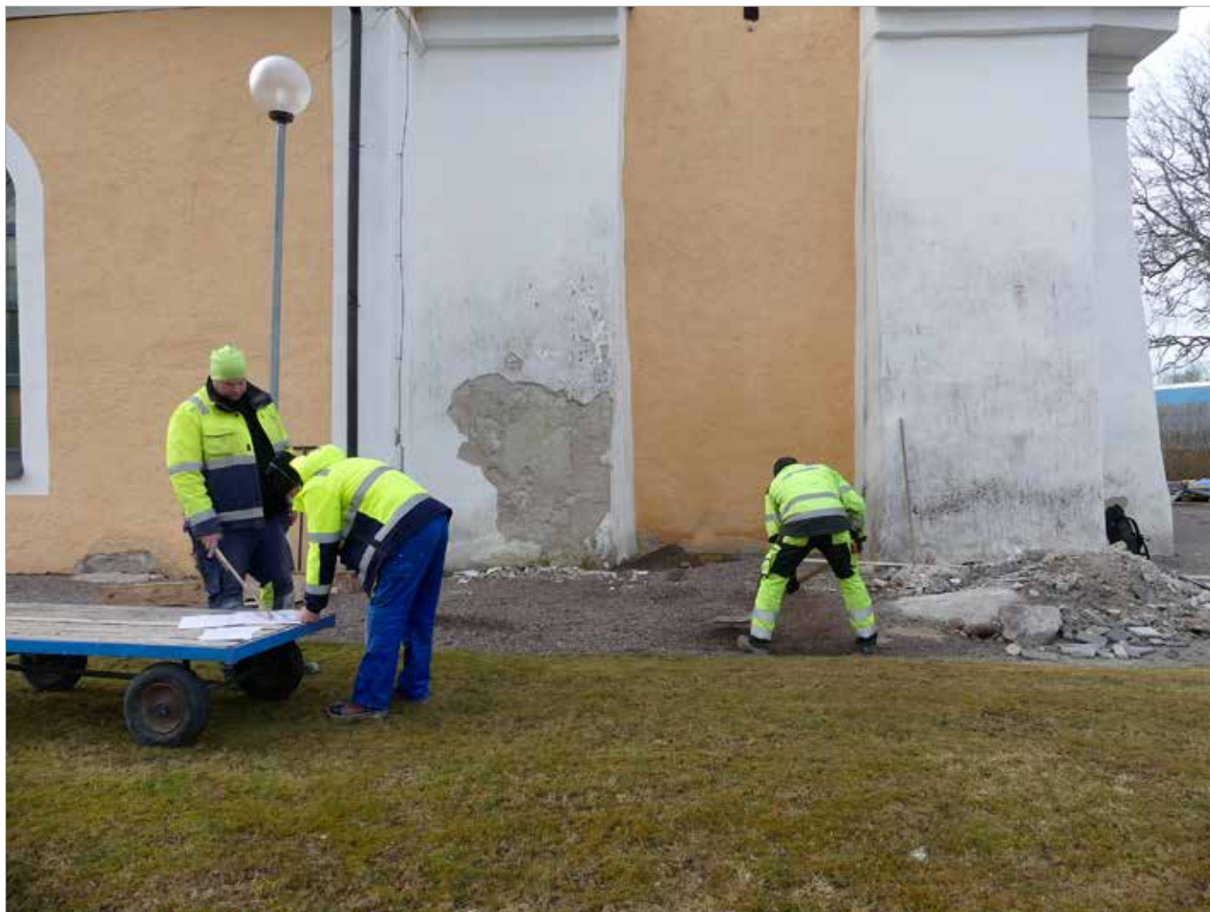
Figur 26. Pågående utvändiga arbete på den norra sidan om tornet. Mot S.
