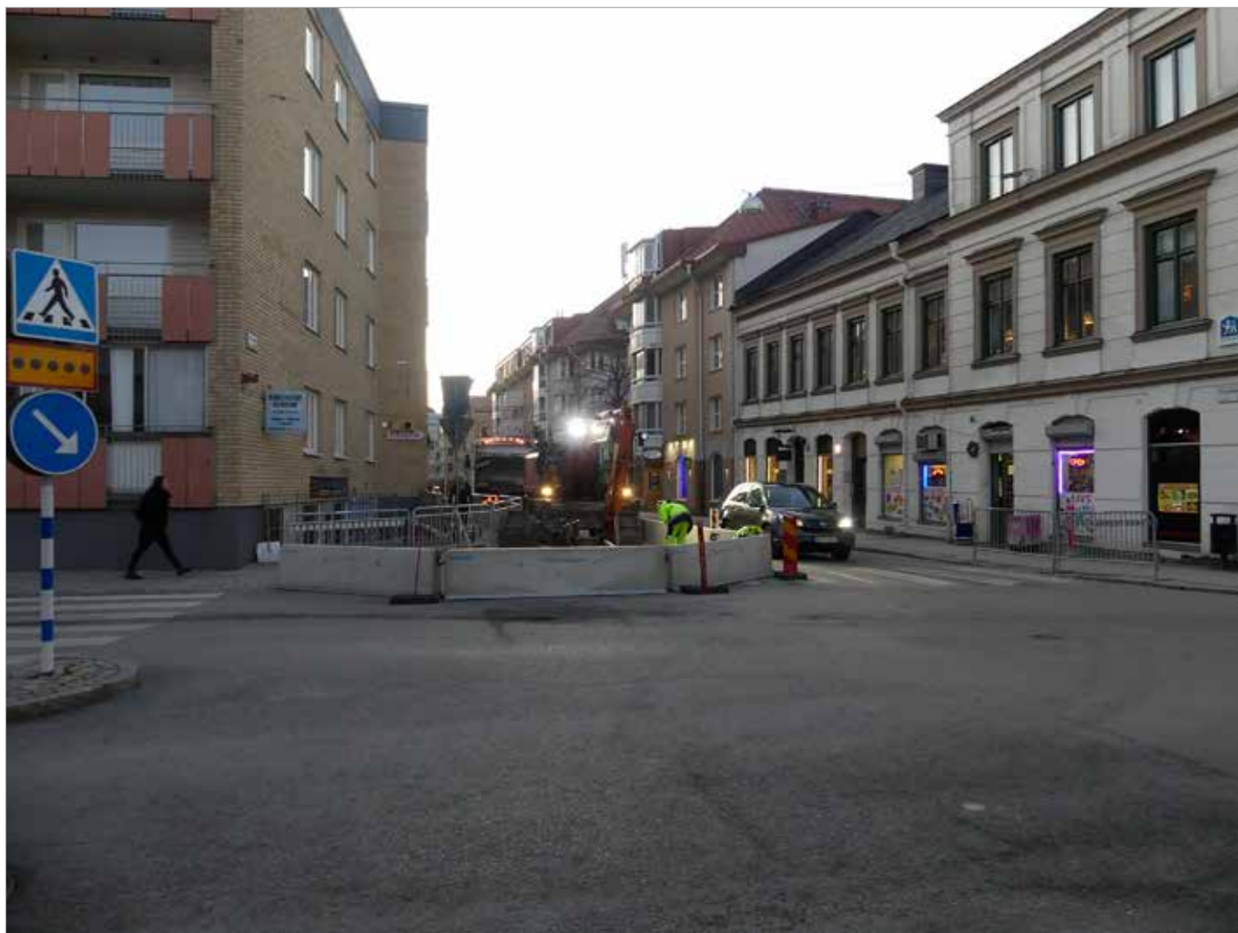
Figur 7. Läget för schakt 1, i korsningen Kungsängsgatan-Bäverns gränd. Foto mot S, Malin Lucas.
