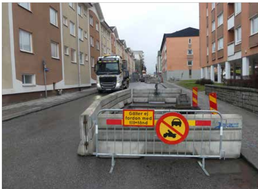
Figur 3. Schakt 1, strax intill korsningen med Tullgatan. Avspärningen för Schakt 2 ansas längre bort i bilden. Foto mot SV, Robin Lucas, Upplandsmuseet.
