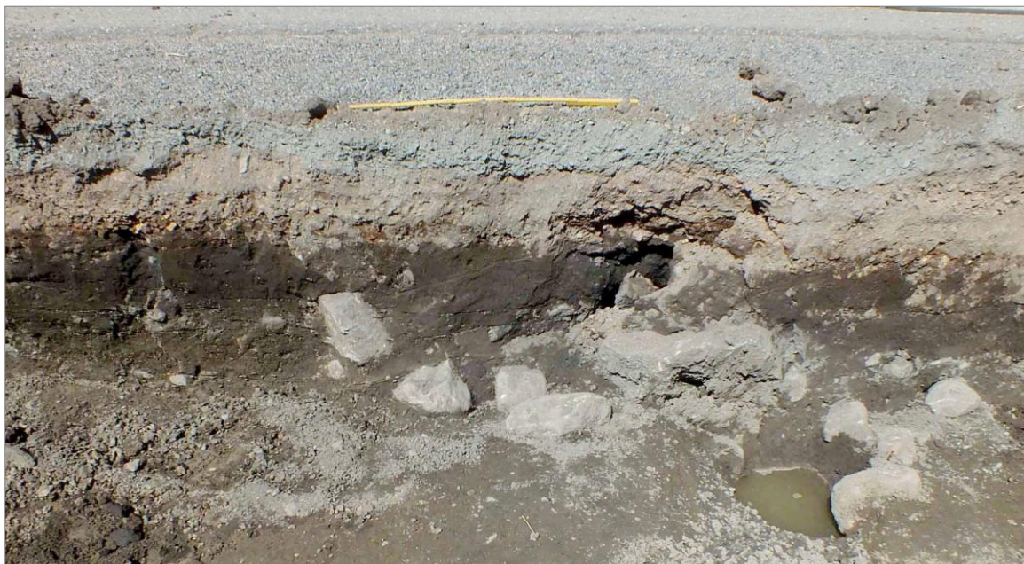
Figur 24. I den norra schaktkanten inom Uppsala 779 fanns flera stenar, varav några med flat ovansida som kan ha ingått i Stensyll 6. Hitom stenarna syns det utgrävda och vattenfyllda stolphålet A904. Foto mot NV.
