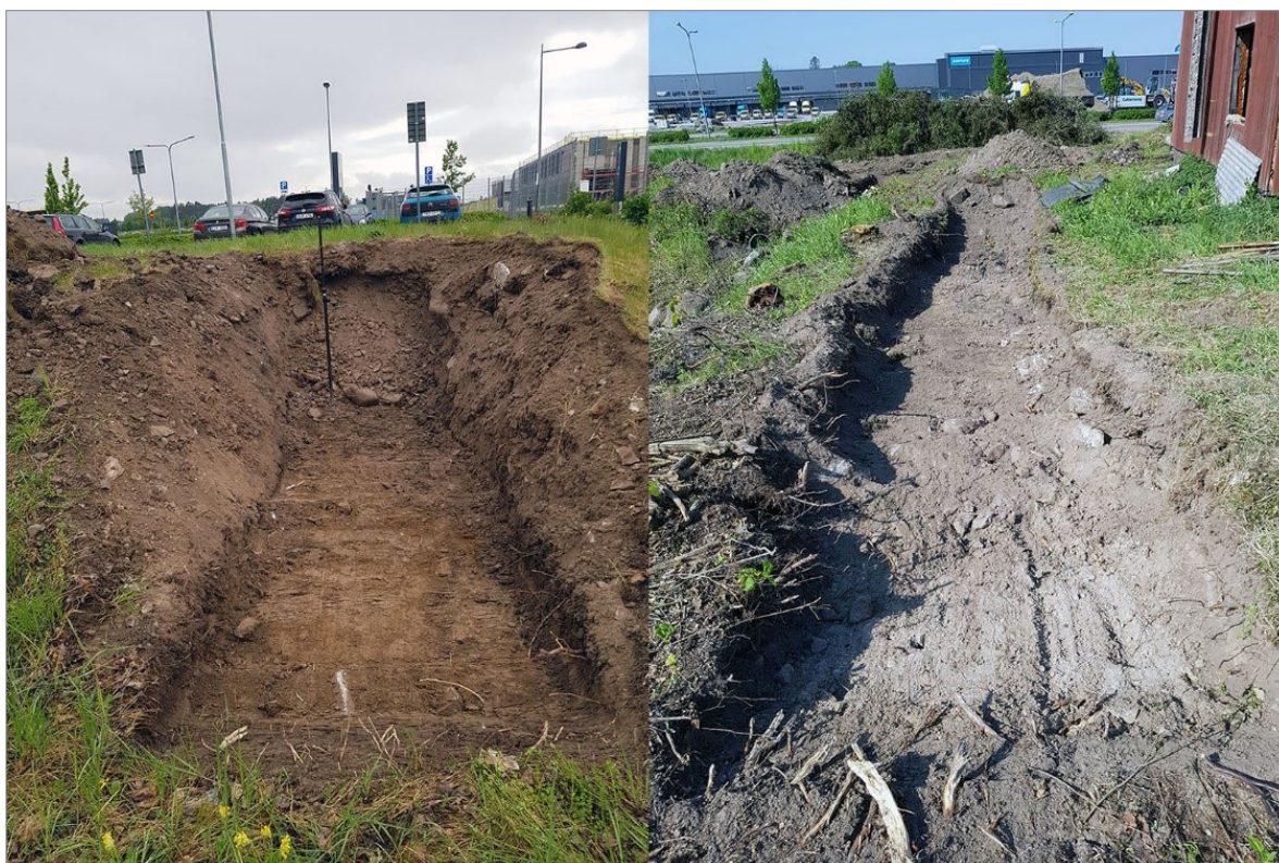
Figur 11. T. v: Påförda massor i schakt 23. T. h: Störningar efter bland annat avlopp i schakt 12. Foto fr. S respektive Ö: Per Frölund.
