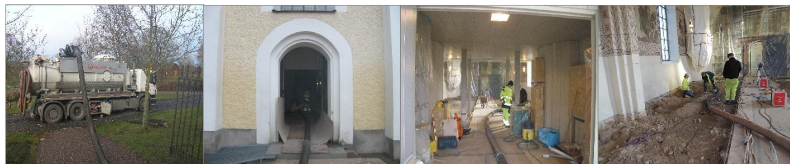
Figur 7–10. Sugbilsslangen leddes in genom kyrkans västportal. Sugstyrkan och hastigheten anpassades så att det var möjligt att övervaka bortforslingen av materialet. Foto figur 7–9 Anna Ölund/Upplandsmuseet, figur 10 (längst till höger) Linda Qviström/Upplandsmuseet.
