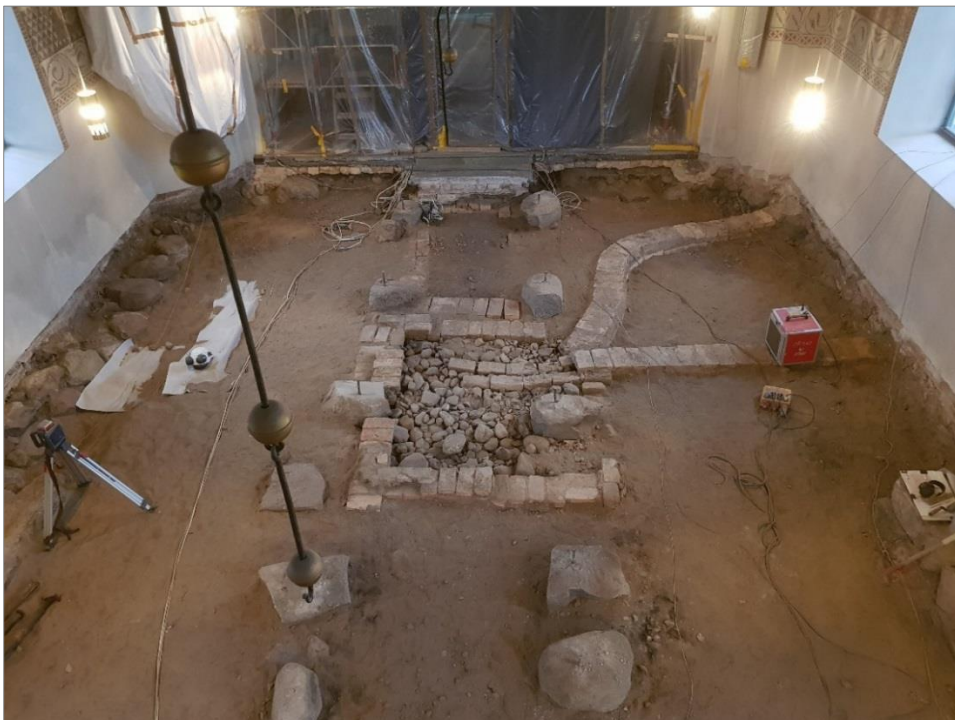
Figur 12 (överst). Översiktsbild över långhuset, efter att fyllnadsmassorna avlägsnats på båda sidor om mittgången. I mitten framskymtar gravkammaren A1, vid sidan av mittgången. Uppe till höger syns den murade värmekanal A5, nere till höger den kalkbruksfyllda rännan A6. Till vänster framskymtar gravarna A12 och A17. Predikstolen är inplastad med anledning av golvarbetena och mot koret har en plastvägg satts upp av samma anledning.
