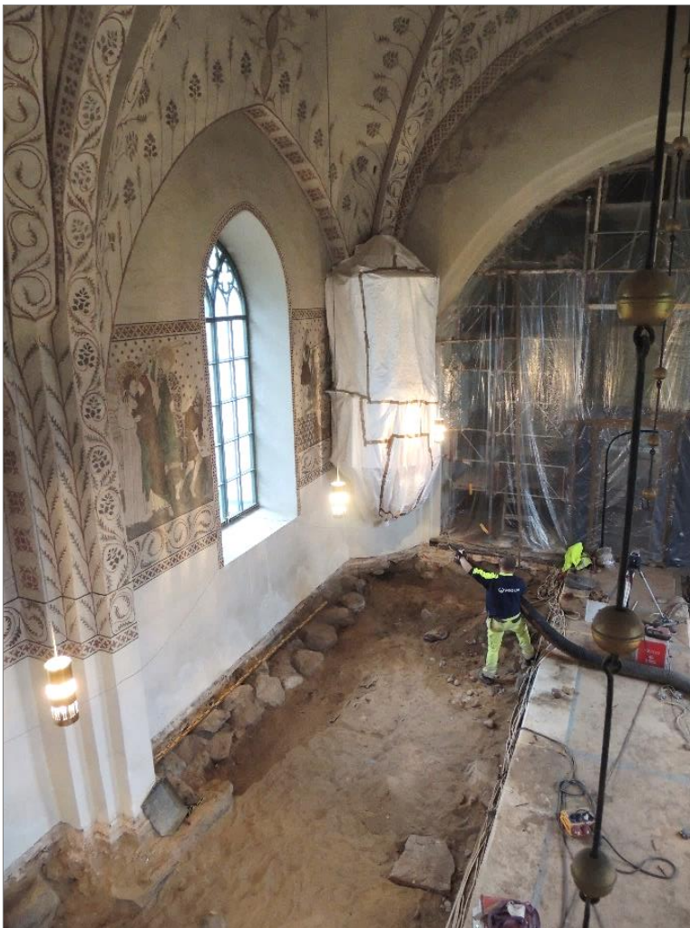
Figur 24. Den nordöstra delen av långhuset under pågående arbete med att forsla bort de sista massorna med hjälp av sugbilen. På väggen syns de bevarade men hårt restaurerade kalkmålningarna. På pelaren till vänster har samma schablon använts som på F14 (figur 26) även om färgerna skiljer sig åt. Foto Linda Qviström/Upplandsmuseet
