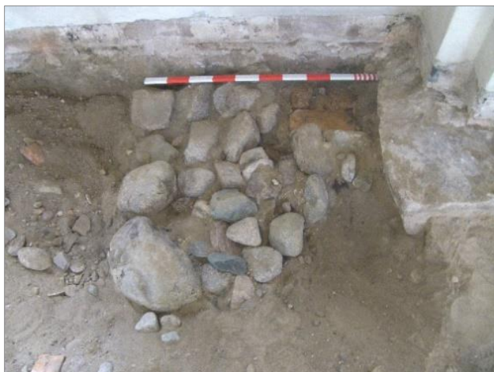
Figur 14. Fundamentet/stenpackningen A4 vid långhusets sydmur. Foto mot söder, Linda Qviström/Upplandsmuseet.
