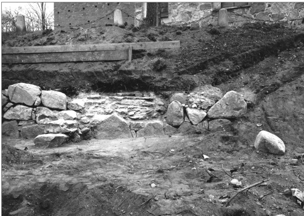
Figur 8. Foto från en undersökning 1933 i västra kanten av Nedre. Slottsgatan, nuvarande Ingmar Bergmansgatan, mitt för Helga Trefaldighets kyrka. Fotot visar på lämningarna av en trappa i slutningen upp mot kyrkan. Trappan bryter igenom en mur som följer slutningens fot. Kyrkan i fotots bakkant. Foto mot SV. Nils Sundquist, Upplandsmuseet.
