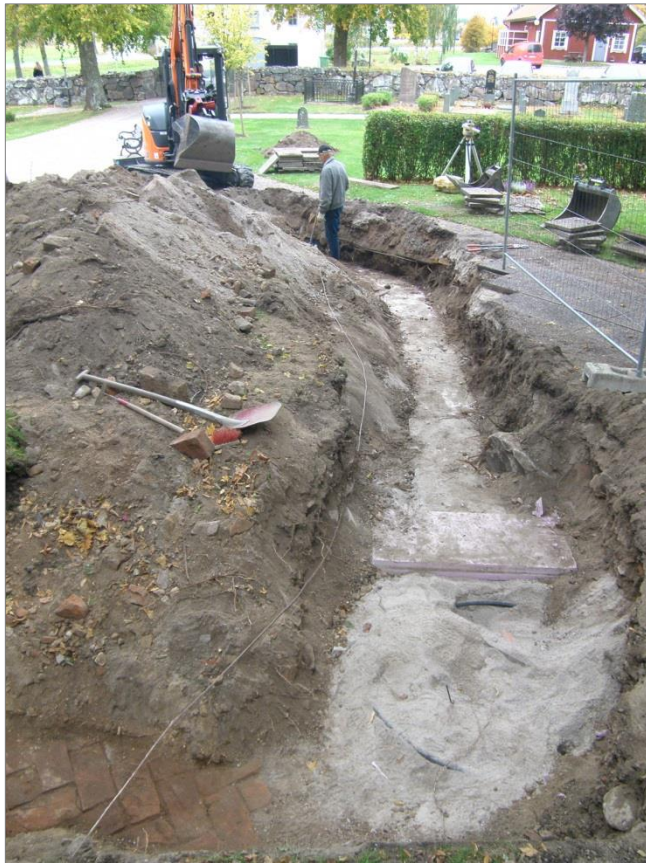
Figur 29. VA-schaktet som följde tidigare grävd sträckning. Foto mot V.
