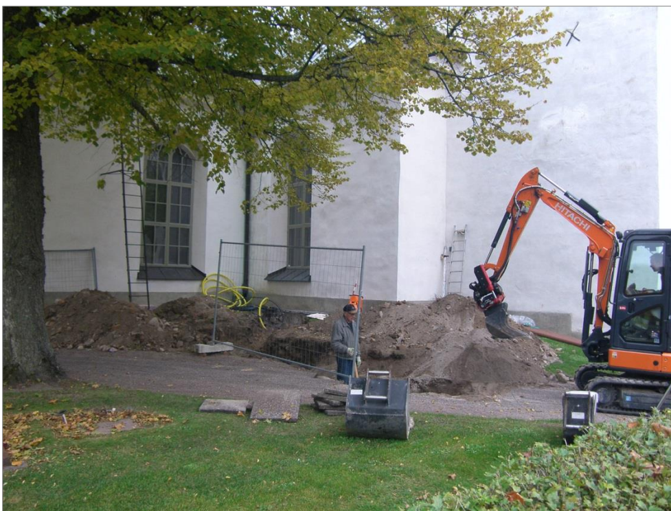
Figur 6. Utvändigt schaktningsarbete vid Alunda kyrkas norra sida. I bild ses en del av tornet, långhuset och den norra korsarmen. Foto mot SÖ.
