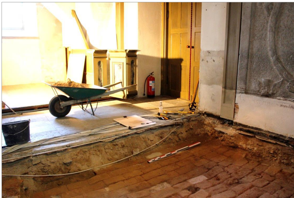
Figur 19. Del av dokumenterat tegelgolv i Alunda kyrka. I bild ses mittgången och den yta som nu tagits i anspråk som lekhörna. Gravhällen i bildens högra kant finns kvar på plats, nu i WC-utrymmet. Dörren i bild leder ut i tornet. Foto mot SV.
