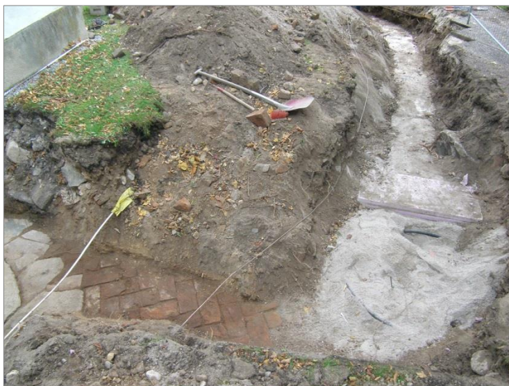
Figur 27. Översikt av påträffat golv samt det tidigare grävda schaktet. Foto mot V.
