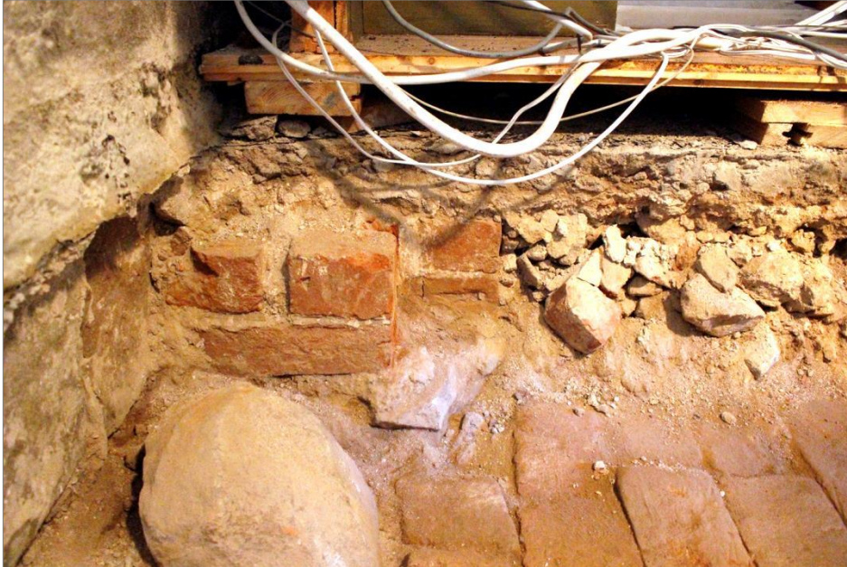
Figur 13. Fundament med oklar funktion i nordöstra delen av ytan. Foto mot Ö.
