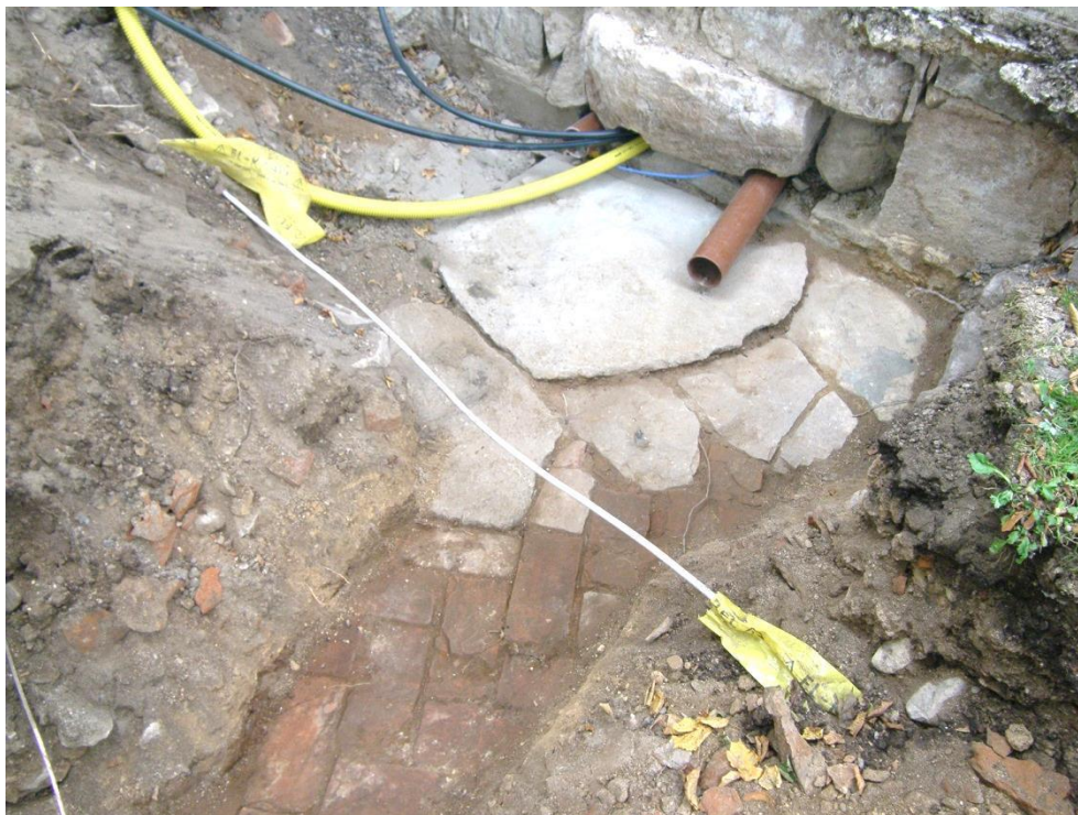
Figur 23. Golvet i det norra vapenhuset utgjordes av flata stenar samt tegel lagt i fiskbensmönster. Foto mot SÖ.
