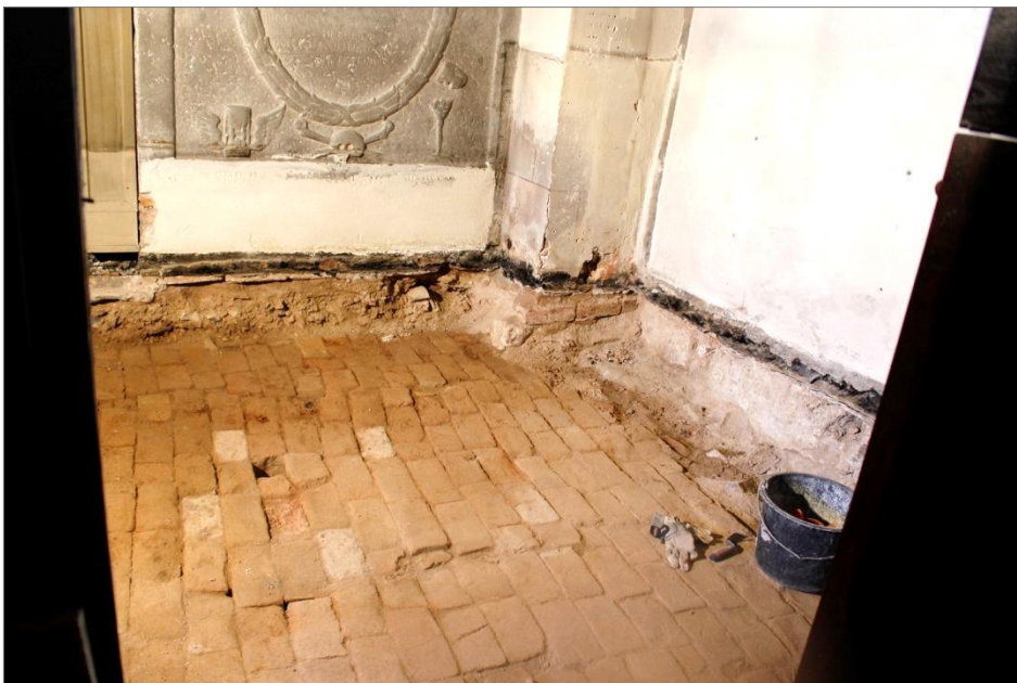
Figur 14. Nordportalens igensättning undersöks. Foto mot VNV.
