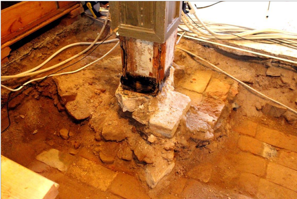
Figur 12. Fundamentet för läktarens pelare. Fundamentet var byggt av tre skift tegel samt sten direkt på tegelgolvet.
