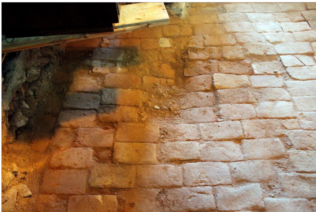
Figur 10. Parti i östra delen av tegelgolvet där en tydlig skarv och försänkning fanns. Sänkan har troligen lagats genom kalkbruk och småsten. Foto mot S.
