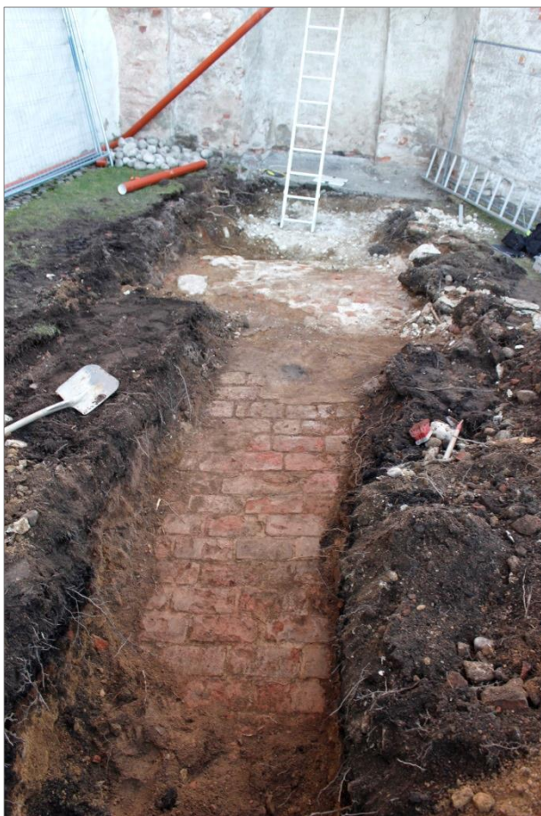
Figur 15. Tegelvalvet i schakt 1. Foto mot SV. Anna Ölund, Upplandsmuseet.
