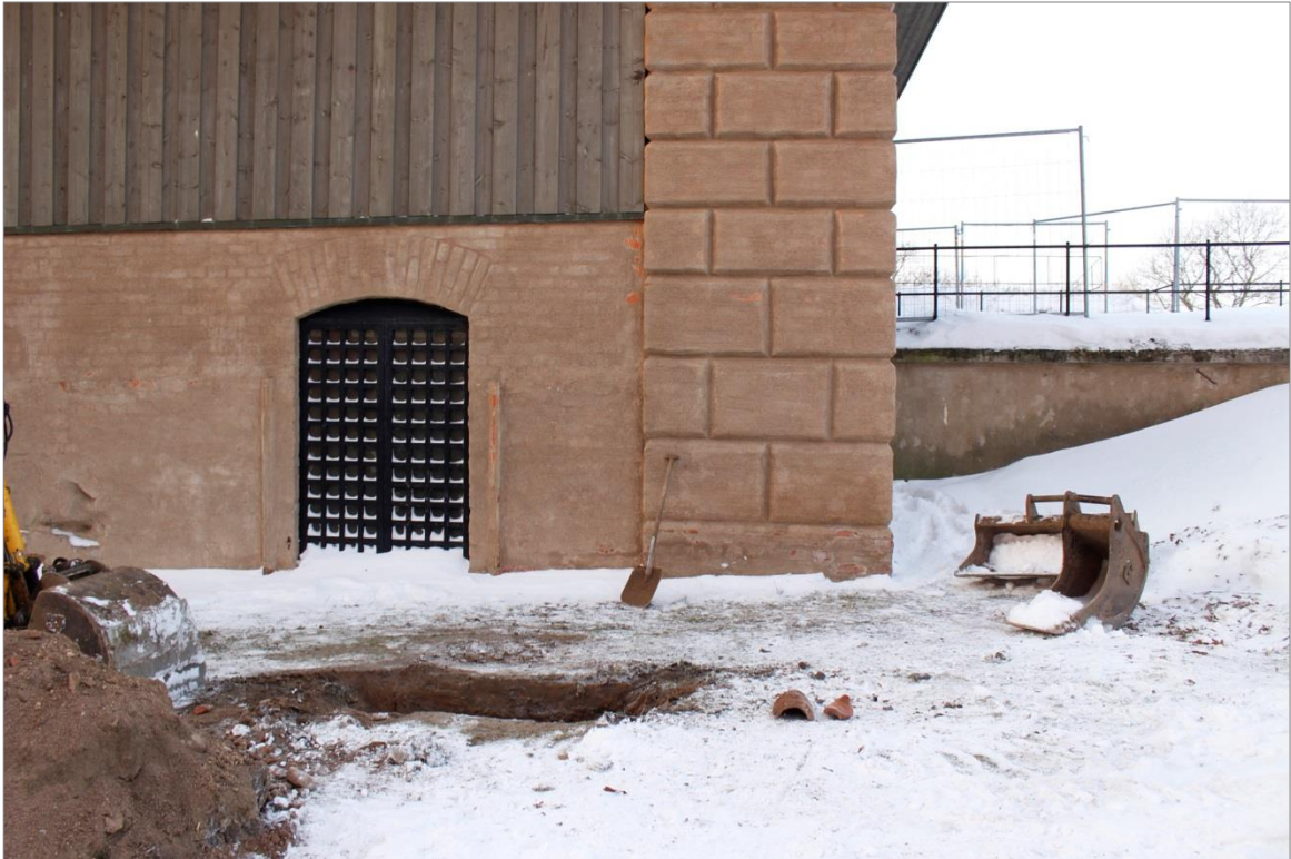
Figur 44. Schakt fyra förlades vid Vasaborgens norra hörn för anslutning till befintlig dagvattenbrunn. Foto mot V. Emelie Sunding, Upplandsmuseet.
