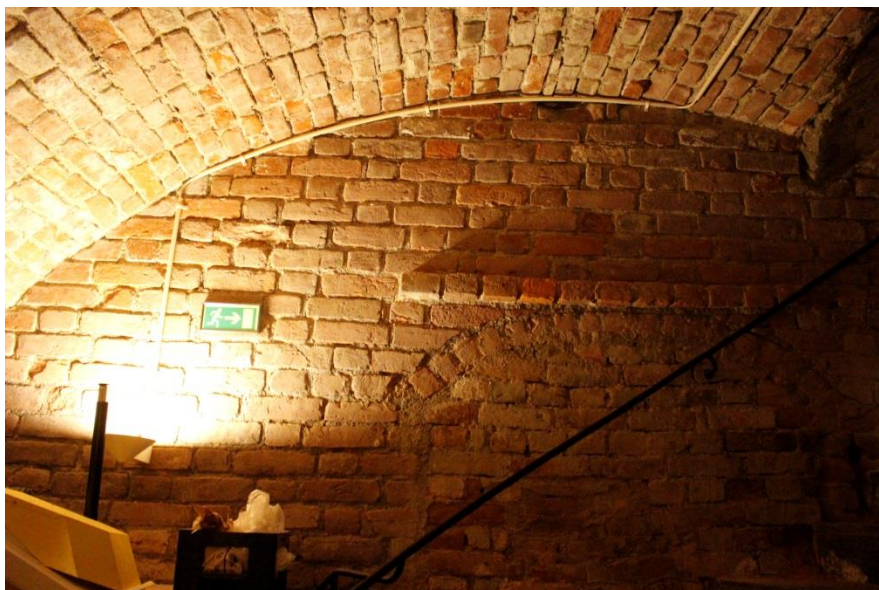
Figur 52. Väggen i Konstmuseets källare som vetter mot väster med den igensatta portalen och droplisten. Väggen är uppförd i vendiskt förband, en förbandsteknik som endast finns i slottets äldsta delar. Foto Anna Ölund, Upplandsmuseet.
