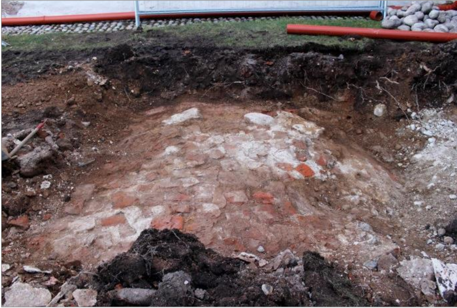
Figur 18. Ovan valvets krön fanns ett skikt med stående tegelstenar och halvtegel sammanfogat med hårt vitt kalkbruk. Troligtvis var detta en förstärkning av valvet. Foto mot Ö. Anna Ölund, Upplandsmuseet
