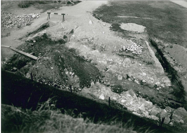
Figur 9. Grundmurarna till Bastion Gräsgårdens äldre flank. Bilden är taget från Gräsgårdens tak. Foto från 1949. Upplandsmuseets arkiv.
