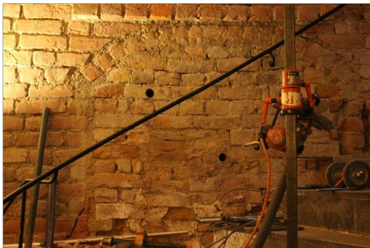
Figur 20. Den igenmurade portalen i Tvärslottets källare med de två borrhålen synliga. Foto mot V. Emelie Sunding, Upplandsmuseet.
