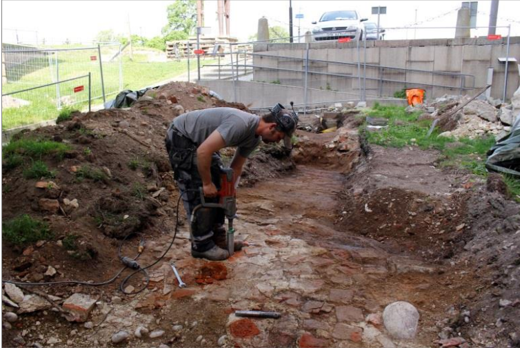
Figur 21. Pågående borrhning, borrhål 1. Borrhål 1 placerades centralt ovan valvets krön och borrhades ca 3 m djupt. Möjligen borrhades här genom en innervägg eller pelare då murat tegel fanns genom hela borrhkärnan. Foto mot NV. Emelie Sunding, Upplandsmuseet.
