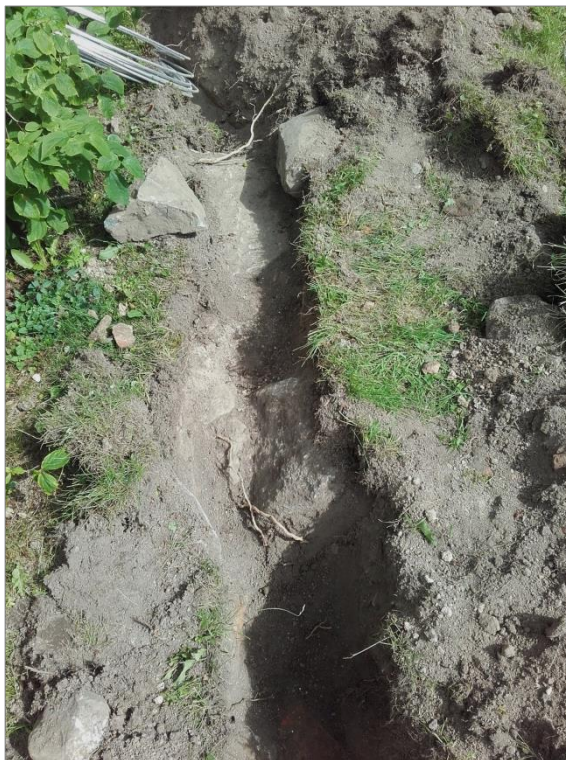
Figur 6. Stenmuren A1 i schaktet öster om korgaveln. Upp mot och på muren fanns kalkbruk. Foto mot N.
