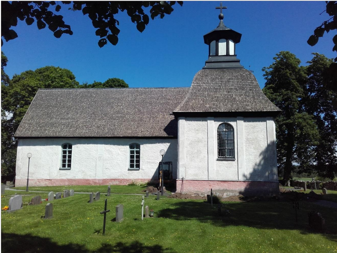
Figur 11. Schaktningsarbetet pågår vid Stureska gravkoret, Teda kyrka. Gravkoret uppfördes under 1680-talet till ägaren av Strömsta gård. Väster om Stureska gravkoret stod fram till 1827 även ett mindre gravhus i trä, Salta gravhus, som uppfördes omkring 1669. Vid schaktningen påträffades rester av en grundmur till Salta gravhus. Foto mot N.
