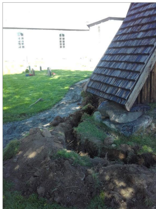
Figur 17. I schaktet vid klockstapeln fanns rikligt med rundad sten blandat med matjord. Sannolikt har sten och jord påförts för grundläggning till klockstapeln. Foto mot N.
