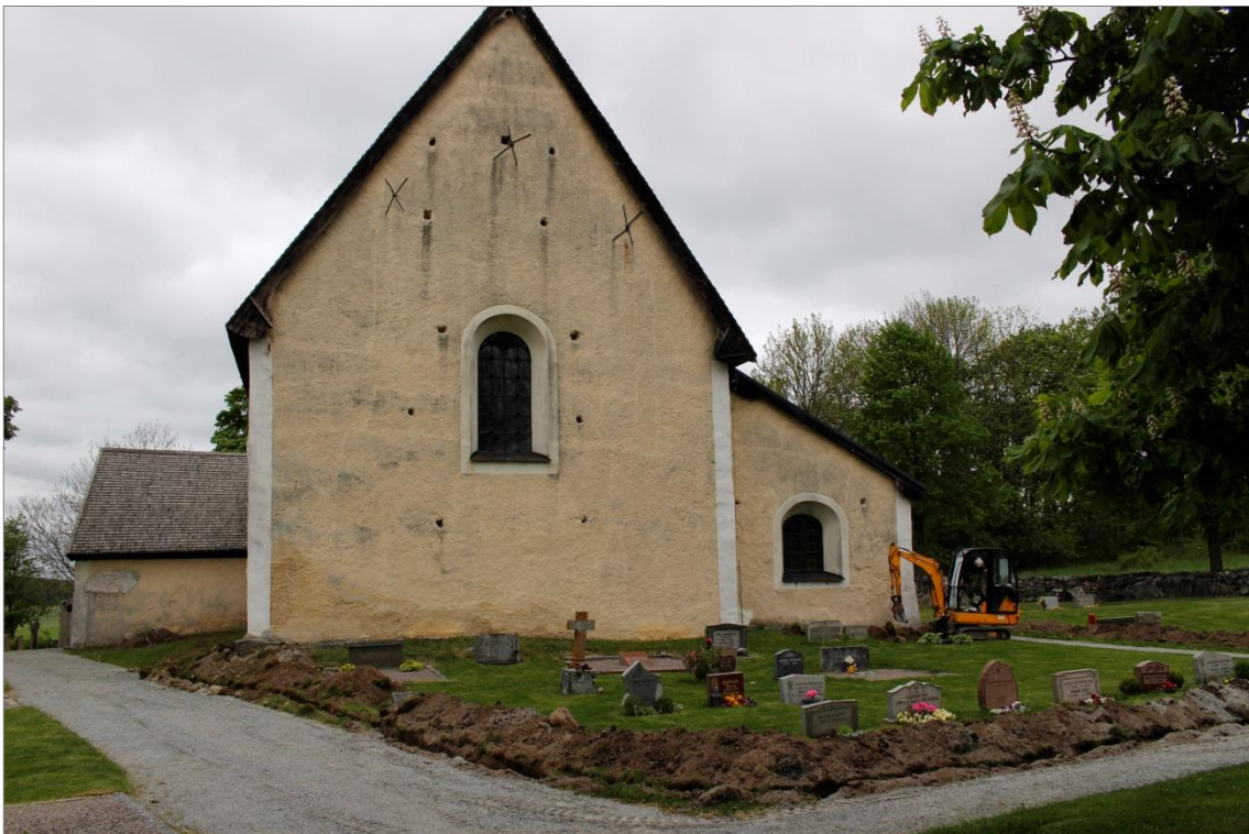
Figur 12. På kyrkans östra sida fick schaktet förlängas och grävas runt gräsytan där flertalet gravar fanns. Foto mot V.
