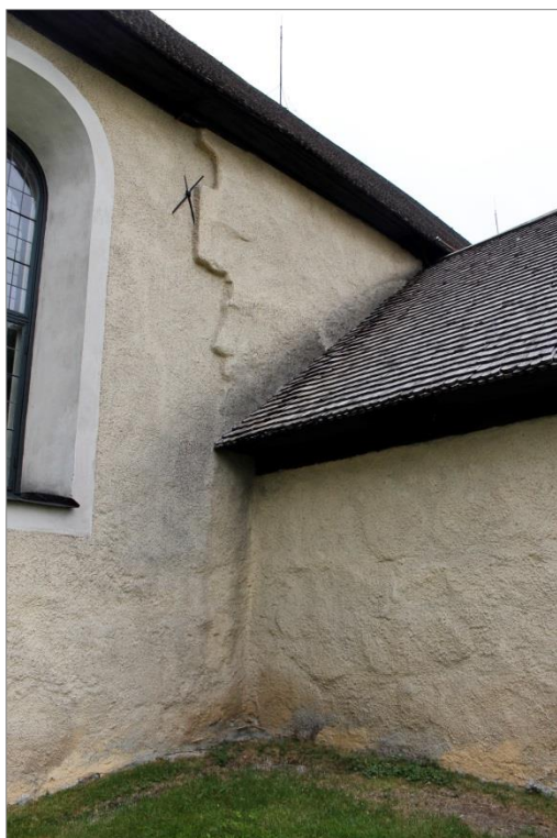
Figur 9. I murverket syntes en skarv i putsen (röd pil) vilket troligtvis markerar vapenhusets ursprungliga storlek. Grundmuren A låg i linje med denna vilket kan indikera att vapenhuset varit längre innan ombyggnationen på 1700-talet. Foto mot N. Anna Ölund, Upplandsmuseet.
