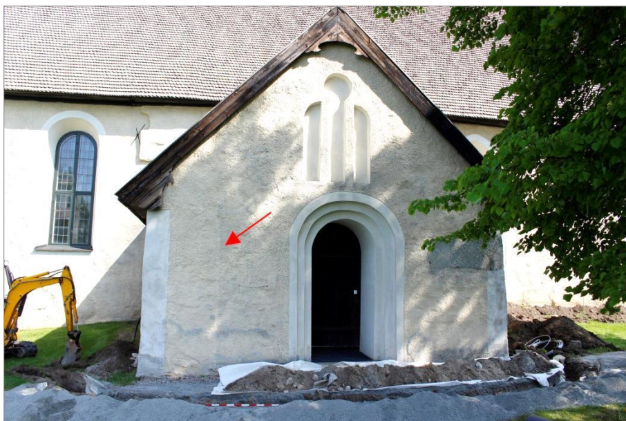
Figur 9. I murverket syntes en skarv i putsen (röd pil) vilket troligtvis markerar vapenhusets ursprungliga storlek. Grundmuren A låg i linje med denna vilket kan indikera att vapenhuset varit längre innan ombyggnationen på 1700-talet. Foto mot N. Anna Ölund, Upplandsmuseet.
