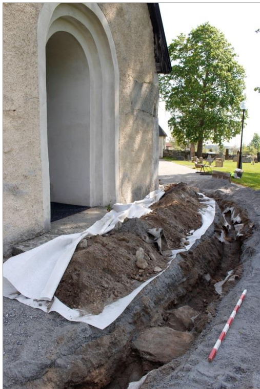
Figur 8. Översikt av schaktet söder om vapenhuset med grundmuren A synlig i nederkant av bilden. Foto Anna Ölund, Upplandsmuseet.
