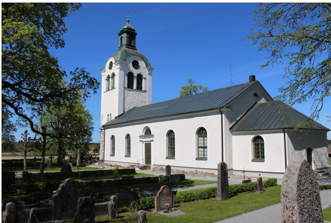
Figur 6. Pågående schaktningsarbeten vid Breds kyrka under i juni 2016. Foto mot NV.
