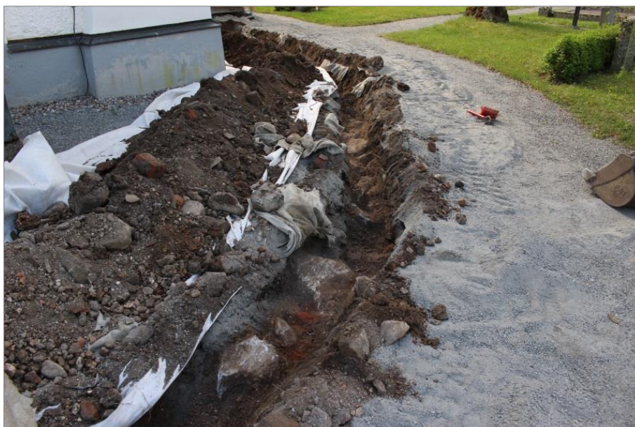
Figur 18. Raseringen E i schaktet längs västgaveln. Foto mot SÖ.
