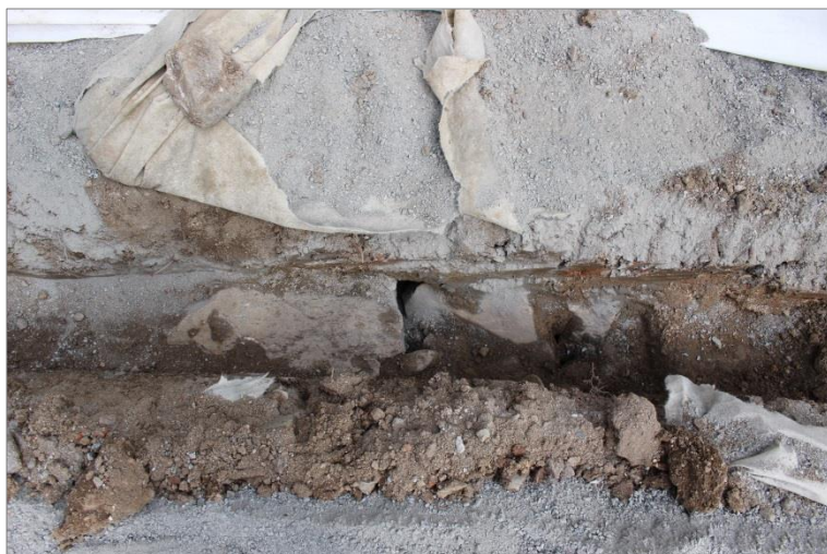
Figur 20. Stenkonstruktionen G som påträffades i schaktet på kyrkobyggnadens södra sida.
