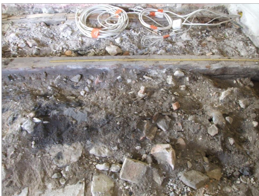
Figur 67. Brandlager A27. Foto mot S.
