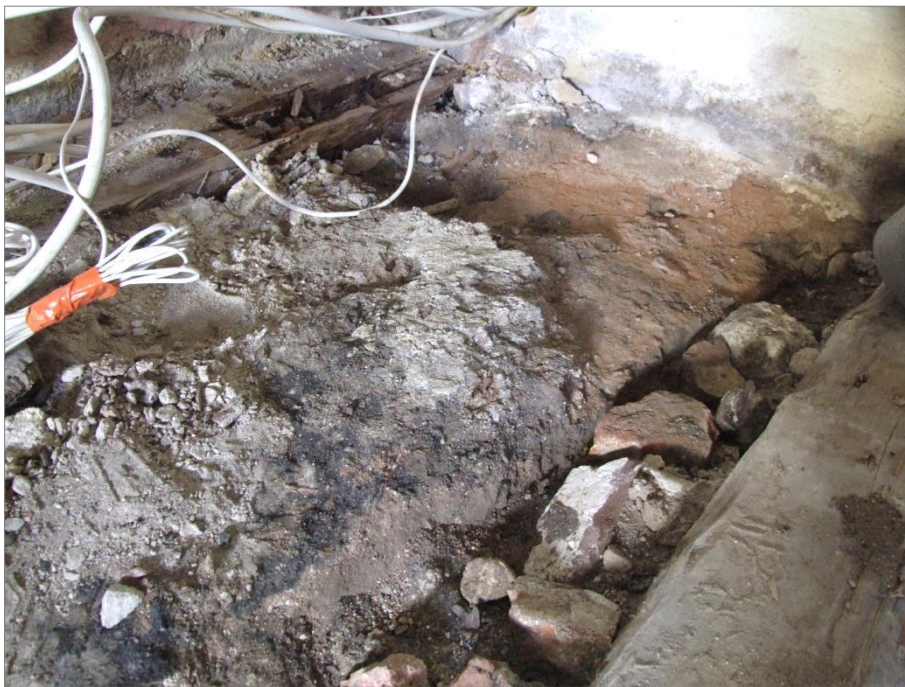
Figur 68. Rester efter äldre golvlager mellan två golvbjälkar. Lagren utgjordes av 2 cm kalkbruk på ett ca 1 cm tjockt sotigt brandlager. Under brandlagret framkom ca 2 cm finkrossat tegel och under detta ca 3 - 4 cm ren lera som i ytan färgats röd av teglet. Foto mot SV.
