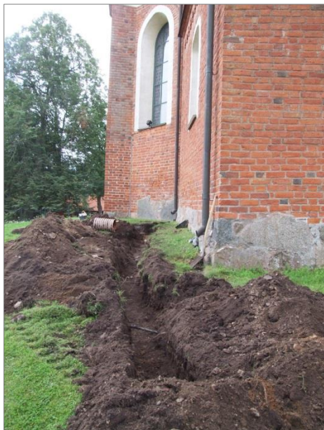
Figur 28. Schakt F längsmed sakristians östra sida. Foto mot S.
