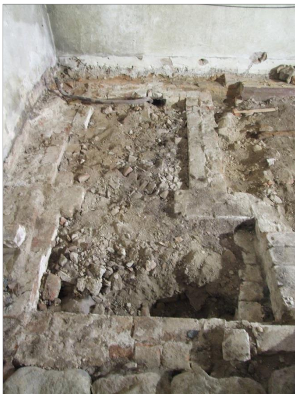
Figur 74. Källarens två rum. Foto mot N.
