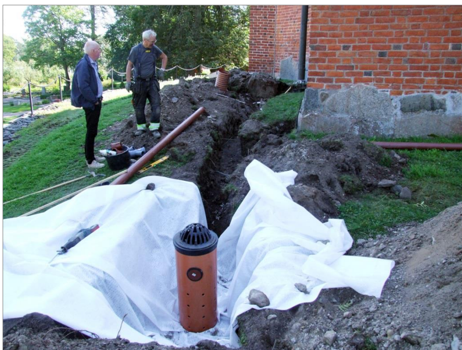
Figur 30. Schakt F i samband med montering av brunn i schaktets N del. Foto mot S.
