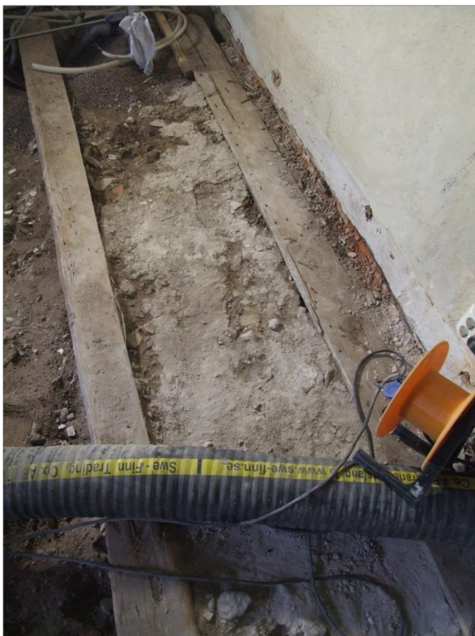
Figur 69. Rester efter äldre golvlager, A29, mellan två golvbjälkar i sakristians sydöstra hörn. Foto mot Ö.
