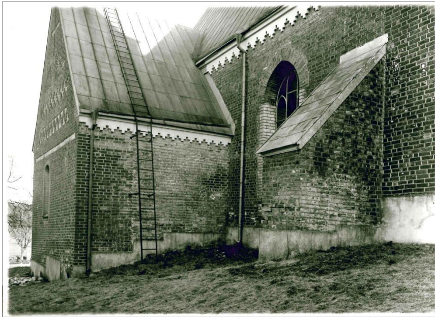
Figur 12. Nuvarande sakristia samt resterna efter den äldre sakristian 1939. I strävpelaren, samt i sakristians västra fasad syns spår efter igensatta portar. Foto mot Ö av Nils Sundquist 1939. Upplandsmuseets arkiv.
