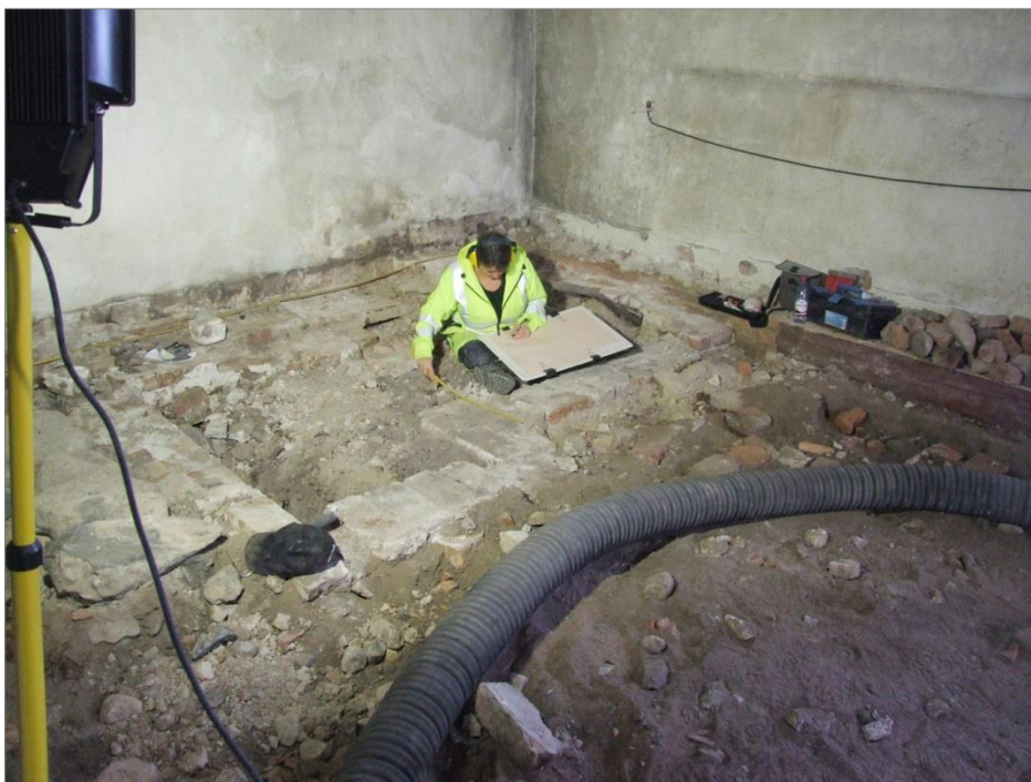
Figur 72. Malin Lucas dokumenterar källaren, A35. Foto mot NV.
