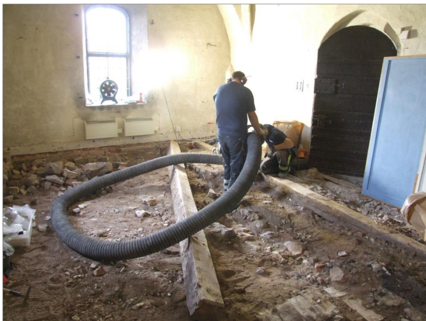
Figur 66. Lager A26 frilagt. Foto mot Ö.
