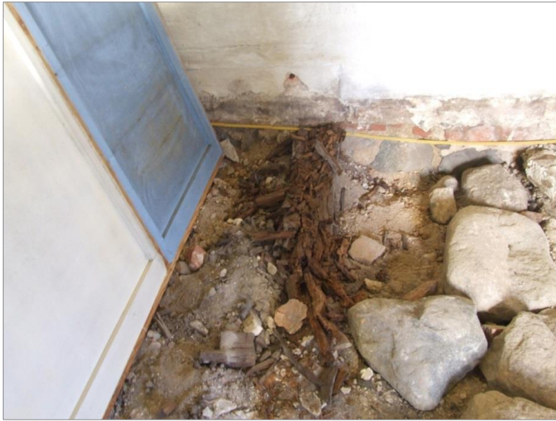
Figur 70. Golvbjälke A33 av multnad furu. Foto mot V av Malin Lucas, Upplandsmuseet.
