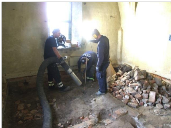
Figur 80. I sakristians sydöstra hörn finns en inskjutande mur från koren som pekar mot att sakristian byggts efter koret. Foto mot Ö.
