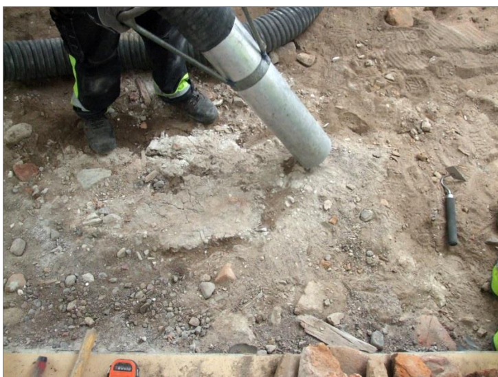
Figur 50. Kalkbrukslager A17 som troligen utgör konstruktionslager till äldre golv.
