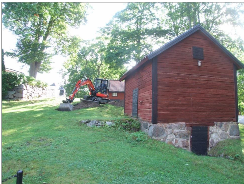
Figur 19. Schakt för dagvatten söder om Danmarks kyrka. Foto mot NÖ.
