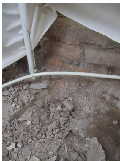
Figur 92. T.v. Bemålade putsfragment i lager A12 invid en strävpelare i långhuset. Putsen knackades ned på 1950-talet och lämnades på platsen. Foto mot SÖ, Malin Lucas, Upplandsmuseet.
