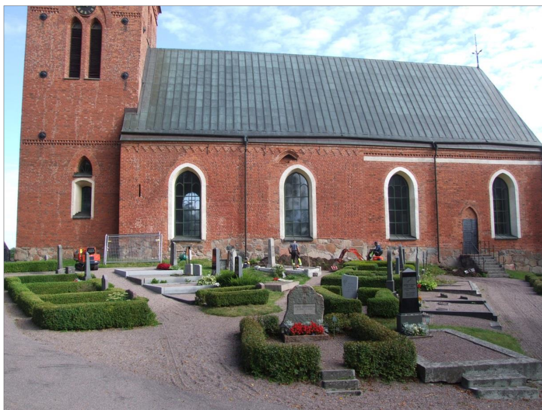
Figur 13. Schaktningsarbete på södra sidan av Danmarks kyrka i samband med anläggandet av nya dagvattenledningar. Foto mot N.
