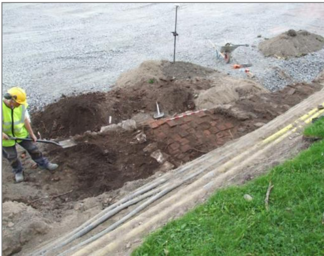
Figur 6. Bakom den avschaktade ytan i väster fanns en omfattande kabelgrav som skulle flyttas. Denna berörde tydliga äldre konstruktioner och även dessa skulle rensas, undersökas och dokumenteras liksom en remsa innanför kabelgraven dit denna senare skulle flyttas. Dan Fagerlund rensar runt ett av tegelugnsgolven. Foto mot SO. Anna Ölund.
