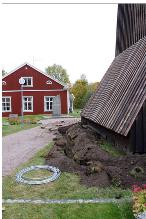
Figur 15. Schaktet vid Boglösa klockstapel. Foto mot S.
