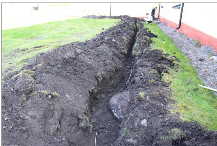
Figur 12. I schaktet längs långhusets norra sida fanns i schaktet ett större stenblock (C) som fortsatte in mot kyrkobyggnaden. Foto mot Ö.
