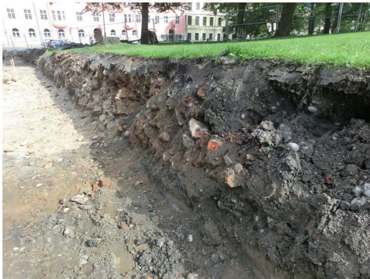
Figur 14. Sydöstra kanten på det långa schaktet där en mängd raseringsmassor i form av tegel fanns. Foto 2014-08-29 mot SÖ.
