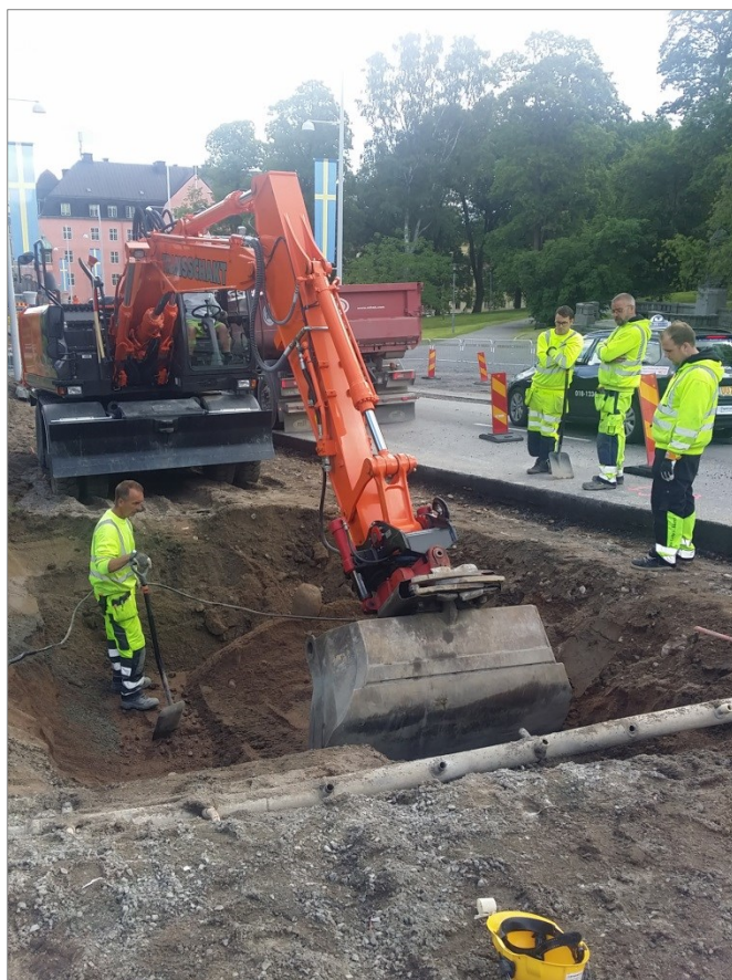
Figur 4. Schaktning pågår strax nedanför Carolinabackens krön. Här ska ett av belysningsfundamenteten gutas. Foto mot NÖ, Emelie Sunding, Upplandsmuseet.
