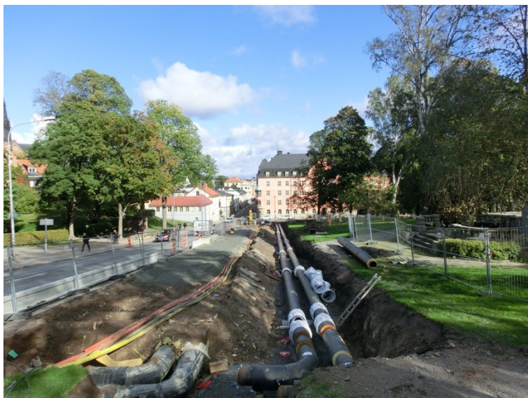
Figur 15. Schaktet färdiggrävt och nya ledningar nedlagda. Foto 2014-09-23 mot SÖ.
