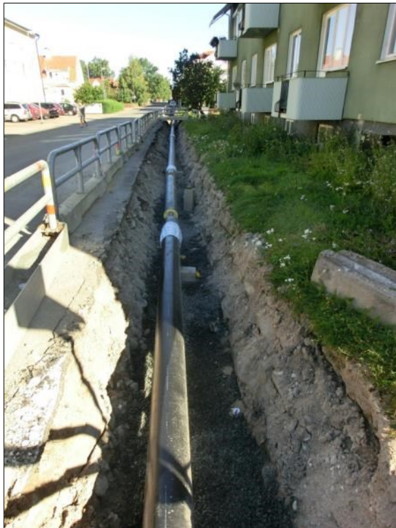
Figur 11. Schaktet i södra delen av Engelbrektsgatan. Foto mot norr, 2015-08-18.
