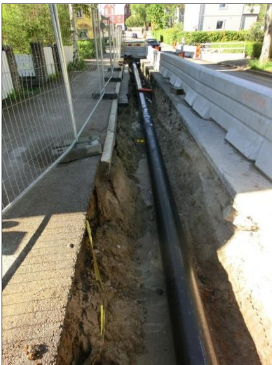
Figur 17. Schaktet i Slottsgatan. Foto mot söder, 2015-05-28.
