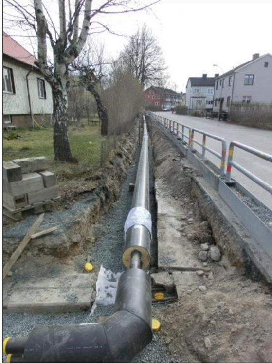
Figur 18. Schaktet i Klockargatan mot Slottsgatan. Foto mot sydost, 2015-04-09.
