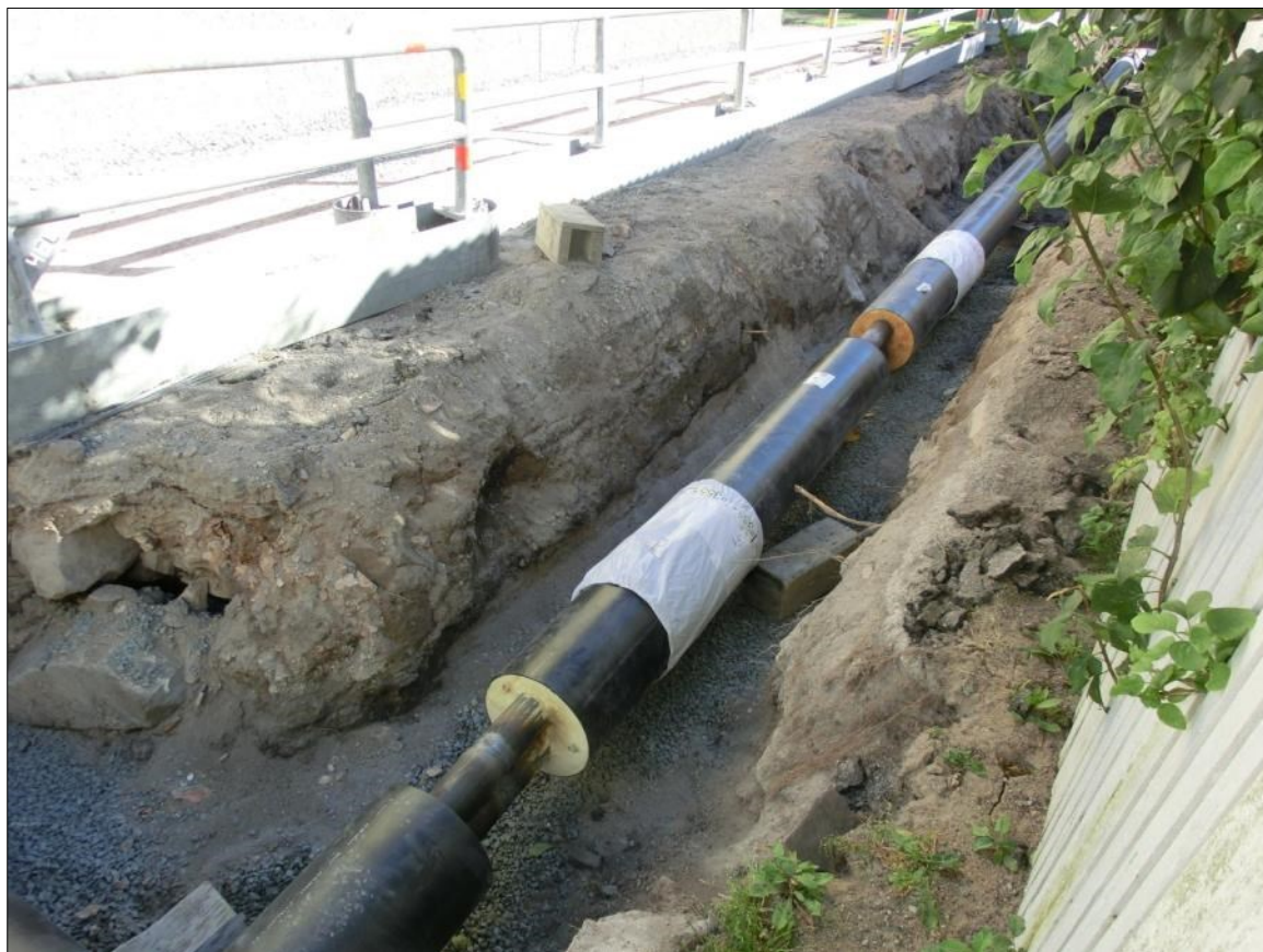
Figur 14. Fjärrvärmeschaktet in i kvarteret Garvaren. Foto mot öster, 2015-08-18.
