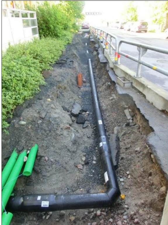
Figur 10. Schaktet i norra delen av Engelbrektsgatan. Foto mot söder, 2015-05-28.
