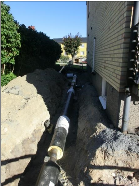
Figur 13. Schaktet in i kvarteret Garvaren från Norra Tullportsgatan. Foto mot norr, 2015-08-18.
