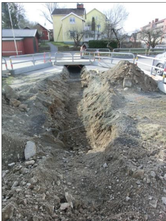
Figur 8. Foto där schaktet korsar Stångörsgatan i östra delen innan anslutning mot etapp 1. Foto mot söder, 2015-04-09.
