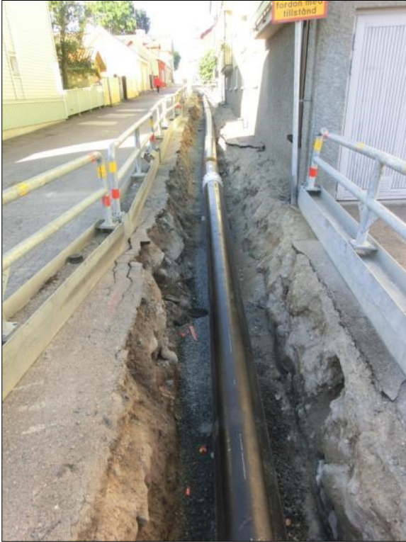
Figur 12. Schaktet i Norra Tullportsgatan. Foto mot väster, 2015-08-18.
