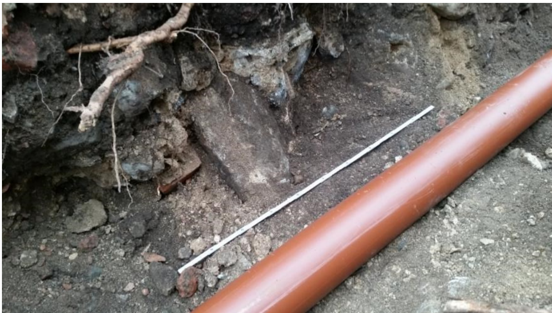
Figur 21. Östra sidan av grunden till en mur. Foto mot sydost, 2015-10-30.
