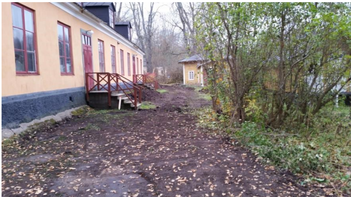
Figur 13. Det igenlagda schaktet på norra sidan av Ekonomien. Foto mot nordost, 2015-10-30.
