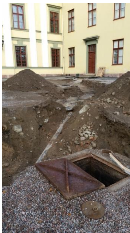
Figur 8 (tv). Foto av spillvattenledningen som kommer från södra flygeln av slottet. Foto mot sydost 2015-10-30. Figur 9 (th). Spillvattenledningen som kommer från norra flygeln. Foto mot nordost, 2015-10-30.
