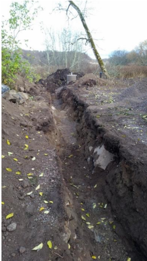
Figur 18. Schakt fram mot infiltrationsanläggningen i norra delen. Foto mot norr, 2015-10-27.
