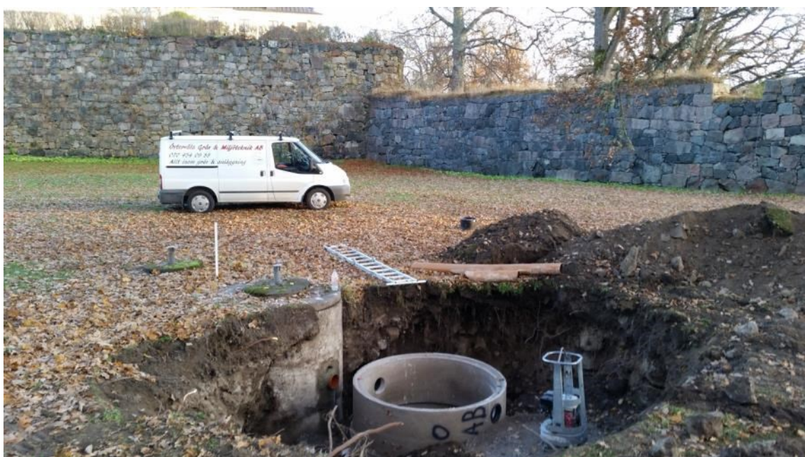
Figur 17. Den kompletterande slamavskiljaren nedgrävd intill den befintliga. I schaktkanten för denna fanns en del stenar och även inslag av tegel. Foto mot öster, 2015-11-03.
