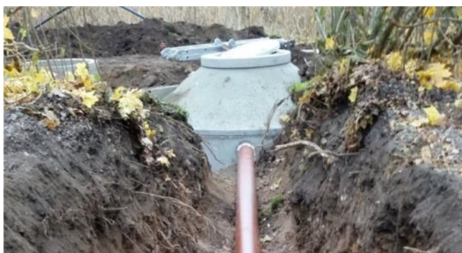
Figur 15. Brunnsslocket till slamavskiljaren i nordöst, som ligger placerad bakom en häck. Foto mot norr, 2015-10-30.
