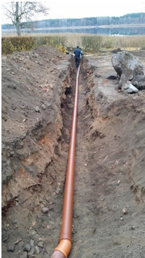
Figur 19. Schakt fram mot slamavskiljaren i nordöstra delen. Vid kröken börjar ett tegellager att öka i tjocklek för att framme vid slutet av schaktet ha en tjocklek av 0,7 m. Foto mot norr, 2015-10-30.
