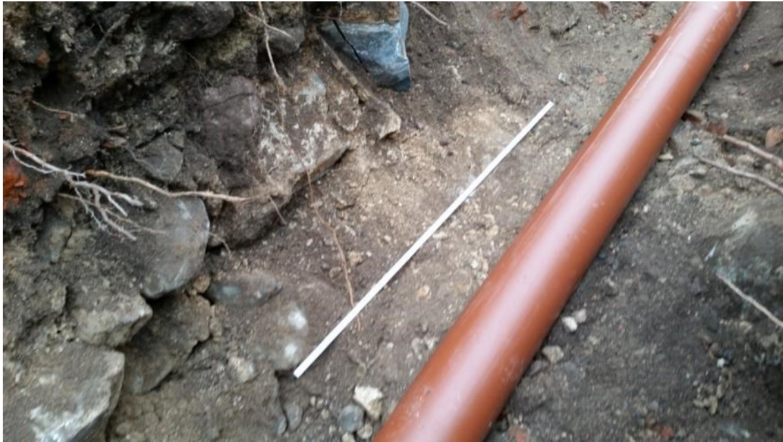
Figur 20. Västra sidan av grunden till en mur. Foto mot nordväst, 2015-10-30.
