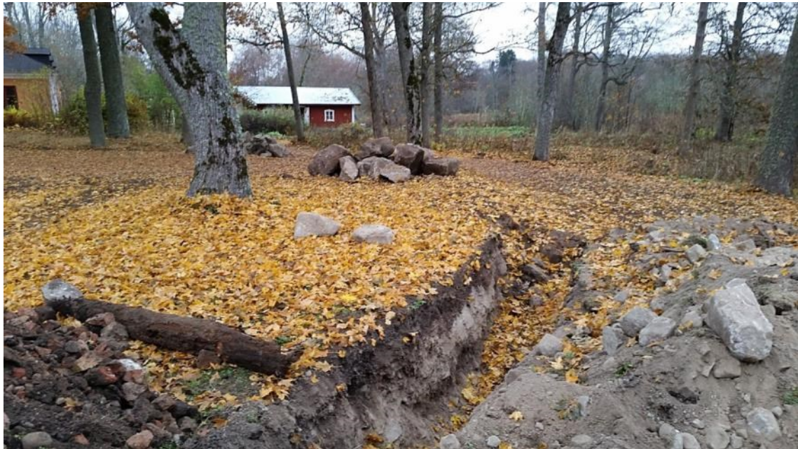
Figur 12. Platsen för ledningsschaktet i parkvägen mellan slamavskiljaren i öster och fram till Ekonomien. När löven fallit och täkt ytan syns inga spår efter schaktningarna. Foto mot nordost, 2015-10-30.
