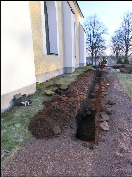
Figur 6. Schaktet efter grävning skett. Foto mot öster, 2014-12-04.
