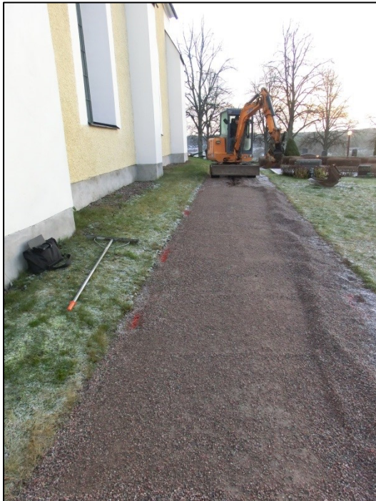
Figur 5. Foto av grusgången där schaktningen skedde från öster mot väster. Foto mot öster, 2014-12-04.
