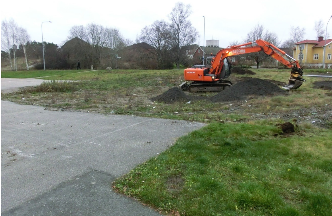
Figur 6. Foto av undersökningsytan. I området runt grävmaskinen och till vänster om denna hade markytan redan den höjd som efterfrågades varför ingen totalavbaning skedde här förutom sökschakt. Den tidigare villan på platsen har dessutom haft en källare som nu var igenfylld med rivningsmassor. Foto från nordväst, 2014-11-18
