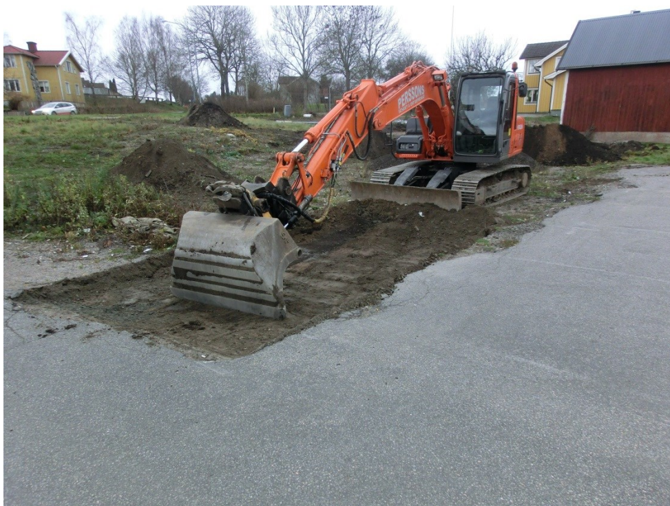
Figur 8. Upptagande av sökschakt strax norr om den tidigare villan. Under ett grus- och sandlager framkom den naturliga markytan, bestående av silt. Foto från nordost, 2014-11-18.
