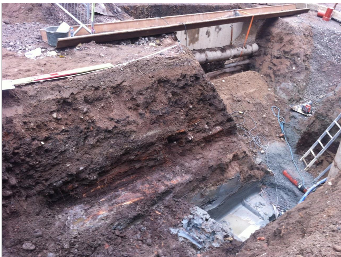
Figur 19. Den östra delen av sektion S1, längsmed den norra schaktkanten i schakt 3. På bilden syns det träskodda diket. Foto mot N, Anna Ölund, Upplandsmuseet.
