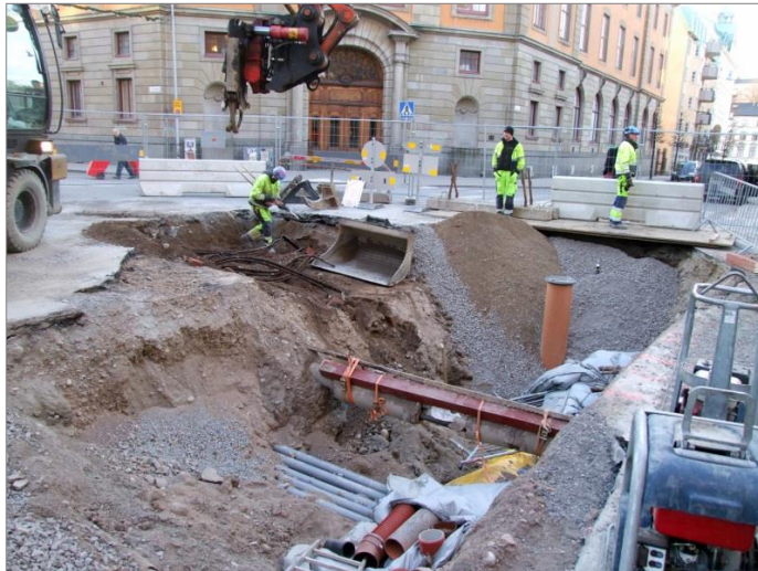
Figur 37. Schakt 3 utvidgas mot söder. Fotot taget i korsningen Bangårdsgatan-Kungsängsgatan mot V.
