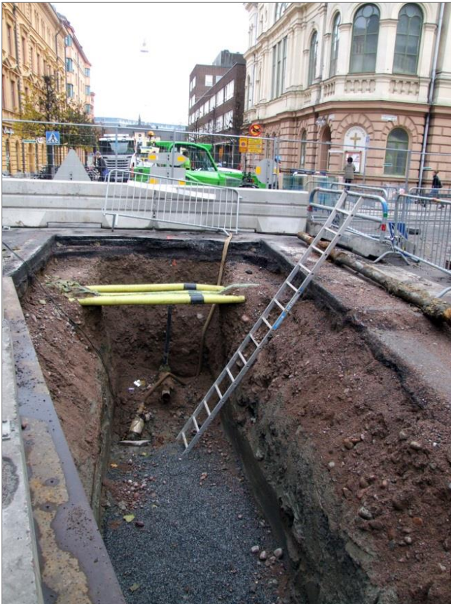
Figur 15. Schakt 1 i korsningen Bangårdsgatan-Dragarbrunnsgatan. Foto mot NÖ.
