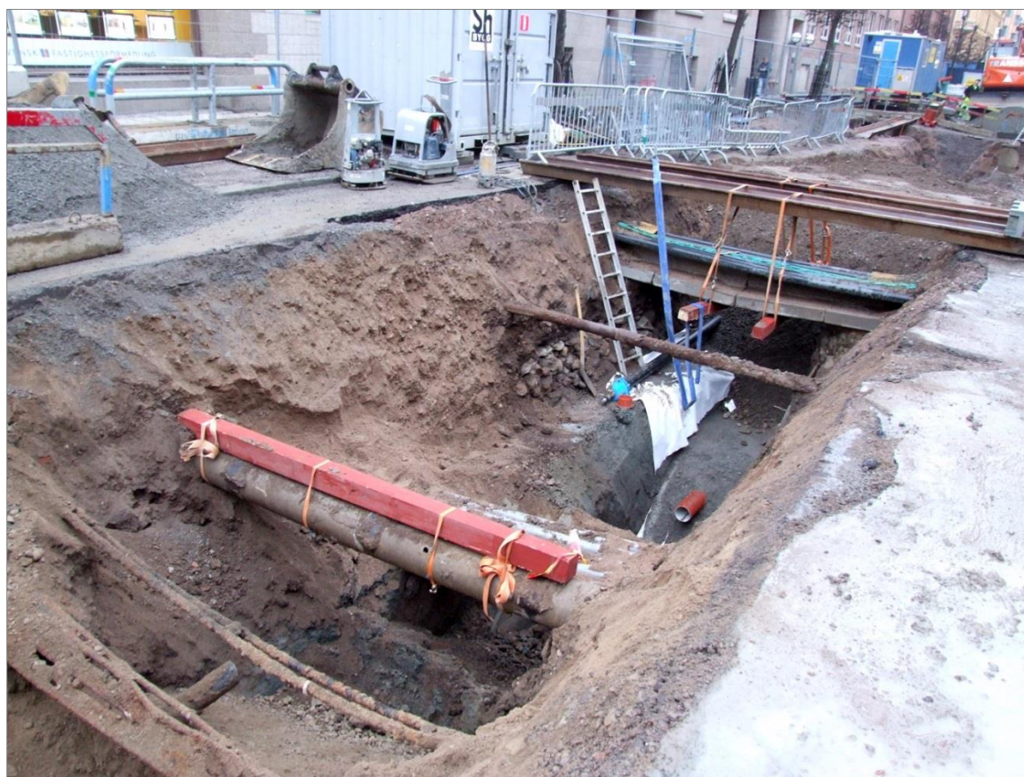
Figur 13. Schaktningsarbetet och den arkeologiska övervakningen försvårades avsevärt av alla äldre ledningsdragningar. På fotot framgår situationen i slutet av november 2013 i västra delen av schakt 3, nära i korsningen Bangårdsgatan-Kungsängsgatan. Foto mot N.
