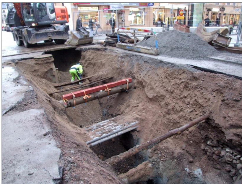
Figur 21. Den södra delen av schaktet närmast korsningen Bangårdsgatan-Kungsängsgatan. Observera det stenfyllda partiet i schaktkanten som utgör en del av dike A3. Foto mot NV.
