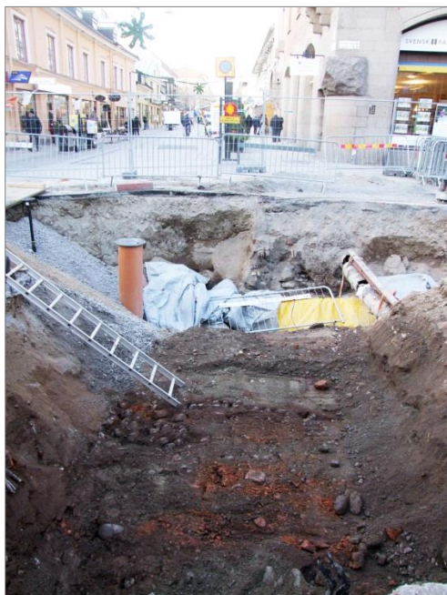
Figur 39. Äldre gatubeläggning av kullersten, A9. Foto mot NV och Kungsängsgatan.
