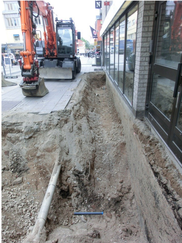
Figur 10. Fjärrvärmeschaktet efter det att det delvis fyllts igen. Foto mot nordöst 2014-05-28.
