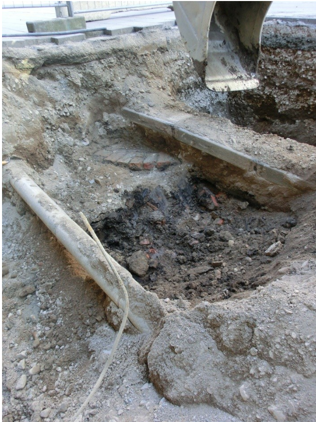
Figur 8. Schaktning i VA-schaktet. Närmst i bild syns trumman för elledningar och bakom dessa teleledningar. Foto mot väster 2014-05-28.
