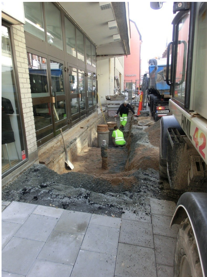
Figur 14. Schaktning utförd vid tillbyggnaden. I förgrunden syns en av de tre pålar som slogs ned. Foto från nordost, 2014-08-12.
