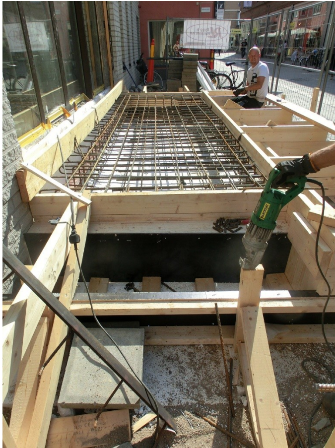
Figur 13. Den vid besiktningstillfället färdigbyggda formen för trappa och ramp vid nya entrén. Foto från nordost, 2014-07-07.
