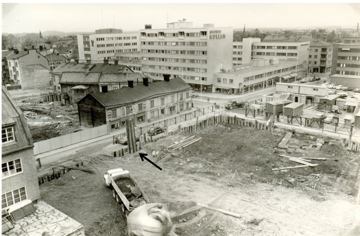
Figur 3. Norra hörnet av kv Kransen med korsningen Dragarbrunnsgatan/S:t Persgatan i bakgrunden. Till höger i bild syns grunderna efter tegelhuset som sträcker sig in under Dragarbrunnsgatan. Vid pilen framkom bogårdsmuren. Foto mot norr av Lars Gezelius 1965, Upplandsmuseets bildarkiv.
