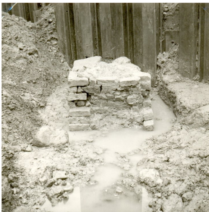
Figur 4. Bogårdsmuren som har sträckt sig in under S:t Persgatan. På fotot syns bogårdsmurens kortsida som utgjort den västra smygen i en port. Foto mot nordväst av Lars Gezelius 1965, Upplandsmuseets bildarkiv.
