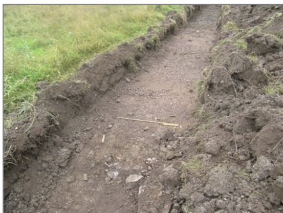
Figur 7. I schakt 172 och 234 förekom breda Grus- och småstensytor som avgränsades av större stenar i kanterna. Det kan röra sig om körvägar från tiden för byggnationerna i området. Objekt 226. Foto från söder. Dan Fagerlund, Upplandsmuseet.
