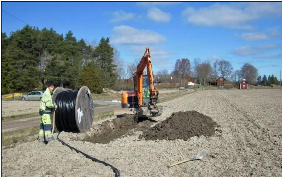
Figur 2. Avbaniing av matjordslagret inom delsträcka 2 intill uppfartsvägen mot gården Fransta. Foto från söder.
