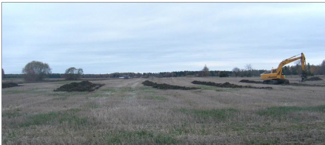
Figur 13. Vy över undersökningsschakten på gravfältets södra del. Foto från söder: Dan Fagerlund, Upplandsmuseet.
