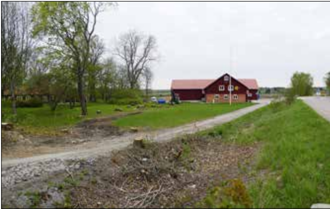
Figur 21. Parkmarken söder om GUSK före avbaning. Notera de kraftiga stubbarna samt gång- och cykelvägen. Foto: Jonas Wikborg, SAU.
