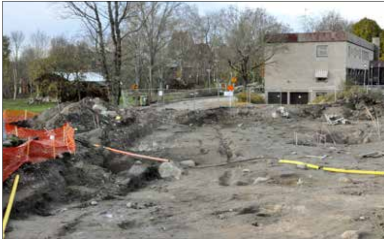
Figur 18. Översikt över väglämningarna i den södra delen av delområdet Storgården (Dy12väg), med kyrkan synlig i bakgrunden. Foto från sydsydost: Anders Bornfalk Back, Riksantikvarieämbetet, UV Mitt.
