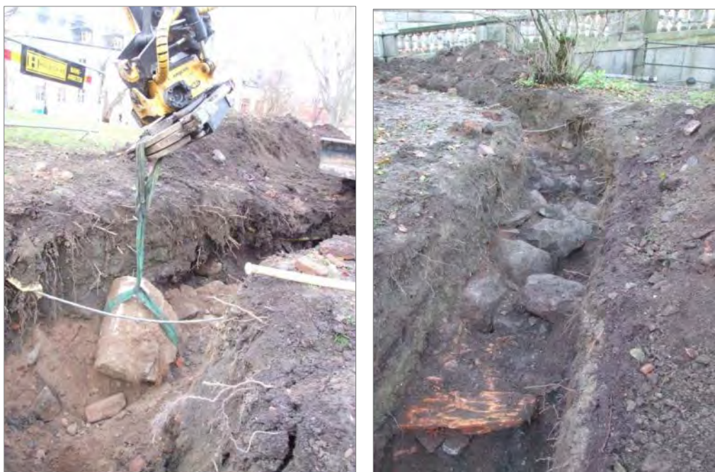
Figur 61 (t.v.). Kalkstensblock F8 lyftes upp ur schaktet. Foto mot N.
