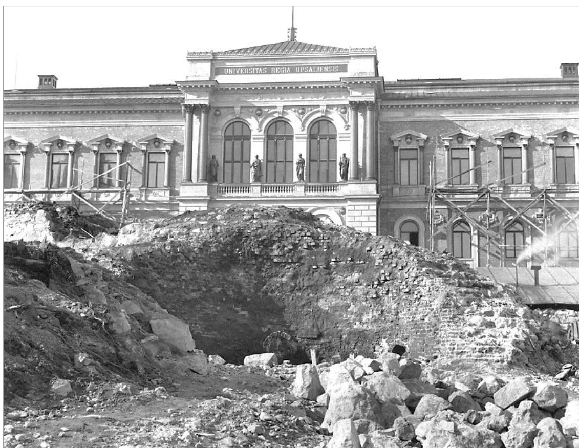
Figur 19. Ärkebiskopsborgens norra torn, Rundeln, låg fram till anläggandet av Universitetsparken som en över mark stående ruin. Rundeln har också gett namn till den intilliggande Rundelsgränd. Tornet var 17,5 m i diam. med 4,5 m tjocka skalmurar i tegel lagt i vendiskt förband med fyllning av gråsten. Tornet som också bar smeknamnet Styrbiskop byggdes sannolikt av Gustav Vasa. Fotot är taget 1886 då universitetshuset var så gott som färdigbyggt. Fotograf okänd (Uppsala universitetsbibliotek).
