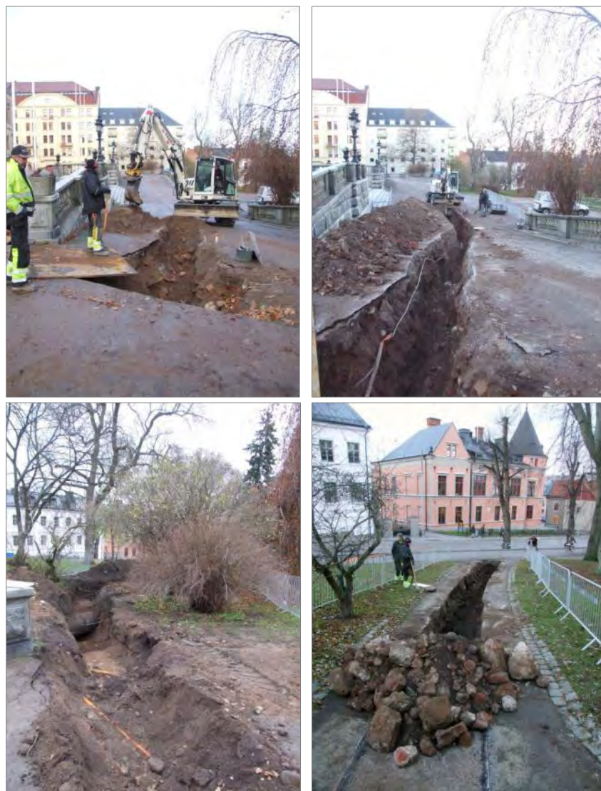
Figur 27-30. Översiktbilder över dagvattenschaktet.
