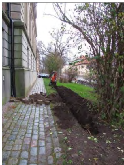
Figur 24 (t.v). Schakt för åskledare längs universitetshusets norra gavel. Schakt 1. Foto mot V.
