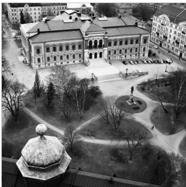
Figur 2. Universitetshuset och Universitetsparken i Uppsala är idag byggnadsminnesmärkta och förvaltas av Statens Fastighetsverk. Foto från domkyrkans torn av Torbjörn Ehrnvall 1961. Foto TE0479, Upplandsmuseet.
