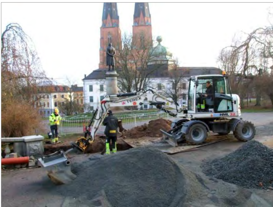
Figur 32. Grävning och dokumentation vid resterna efter ärkebiskopsborgens norra mur. Foto mot NO Joakim Kjellberg, Upplandsmuseet.
