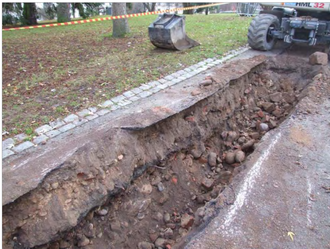
Figur 67 (nedan). Generell kulturlagerbild i schakt 6 med två kraftiga raseringslager och en mellanliggande markhorisont. Foto mot Ö.
