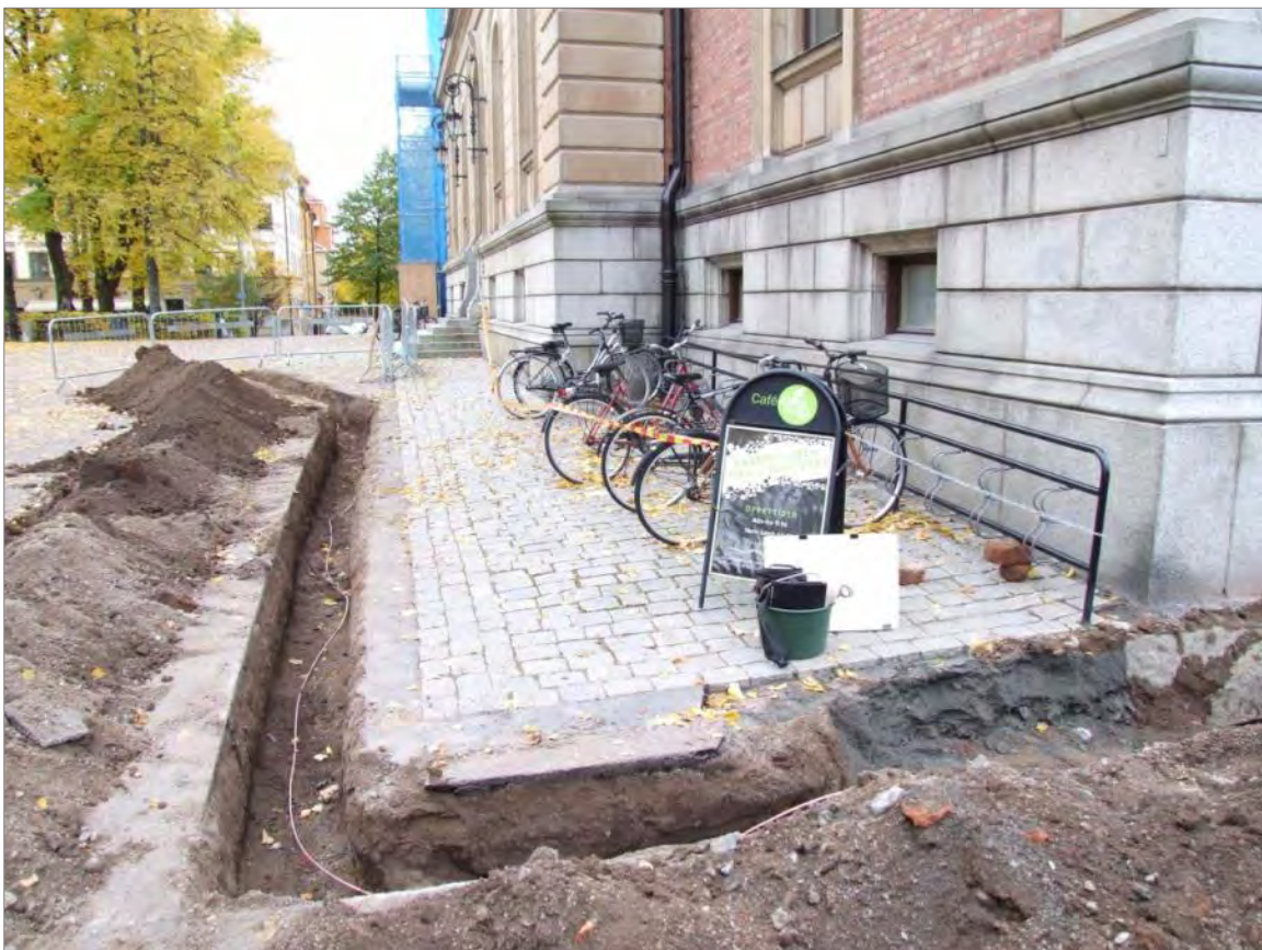
Figur 26. Schakt för åskledaren vid universitetshusets södra gavel. Foto mot SV Joakim Kjellberg, Upplandsmuseet.
