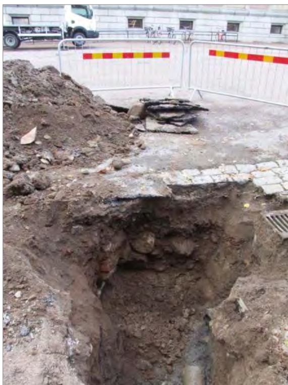
Figur 44. Mur A8 i kanten på schaktet. I bakgrunden skymtar universitetshusets sockel. Foto mot SV.
