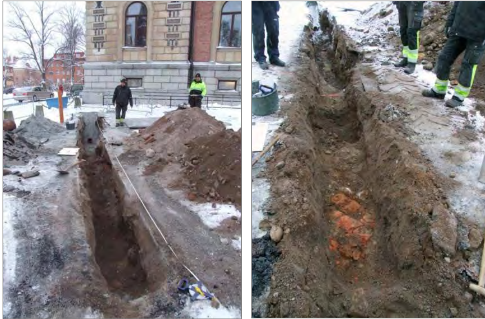
Figur 40 (t.h). Översikt över schakt 3, där resterna efter mur A6 anas i schaktet. Foto mot S.
