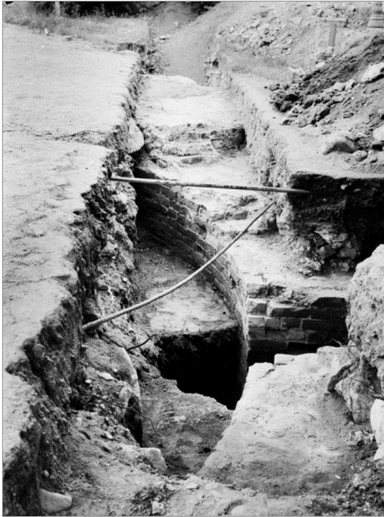
Figur 8. Delar av ärkebiskopsborgens norra rundel vilken framkom i samband med grävningar för kulvertnedläggning 1954. Foto mot väster. Fotograf okänd. F639_04. Upplandsmuseet.
