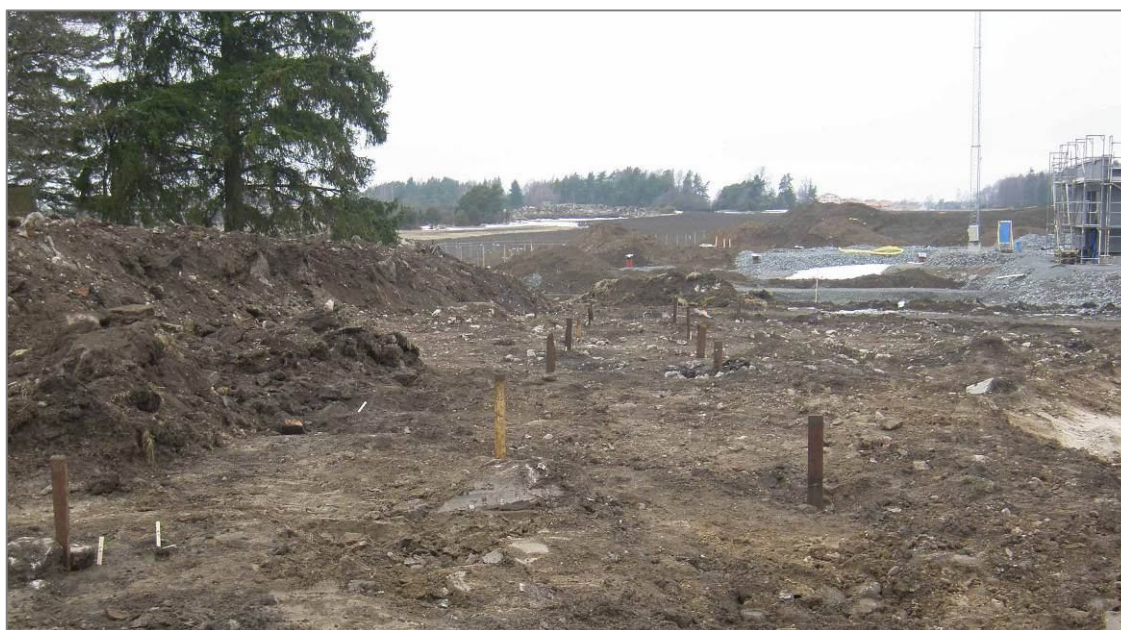
Figur 5. Nordväst om Söderhällby låg gravfältet Inhåleskullen. Detta syns som den steniga höjden mitt i bildens bakkant. I förgrunden syns hus 16 från SO. Bilden illustrerar också det mycket snäva förhållandet mellan undersökningen och exploateringen och de mycket tjocka fyllnadslager som täckte fornlämningens centrala delar. Foto (fr. SO): Dan Fagerlund, Upplandsmuseet.
