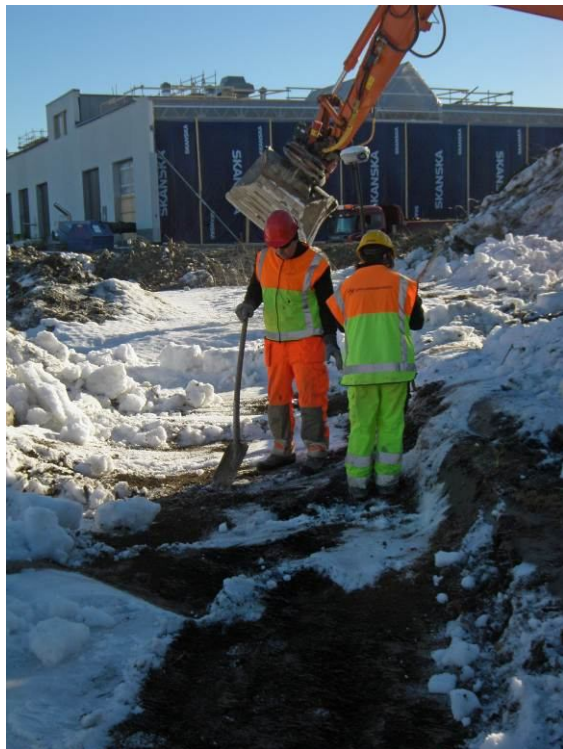
Figur 8. "Här måste det vara". Arbetet återupptogs i mars 2011 och byggnationen hade krupit tätt upp mot det återstående undersökningsområdet. Malin och Robin Lucas söker efter de gamla schaktkanterna med mätinstrumentet och snöskyffel. Foto (fr. V): Dan Fagerlund, Upplandsmuseet.
