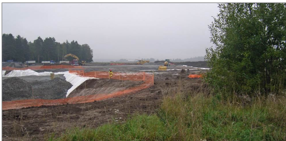
Figur 40. Under sen höst 2010 kom byggnationen att krypa tätt in på undersökningsytan. Mätning i området för hus 7, 8 och 12. Foto (fr. NV): Dan Fagerlund, Upplandsmuseet.
