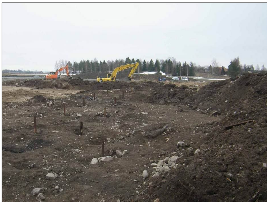
Figur 4. Från undersökningsplatsen i Söderhällby syns Nederkumla by i bakgrunden. I förgrunden markerade stolphål som ingår i hus 16. Foto (fr. NV): Dan Fagerlund, Upplandsmuseet.
