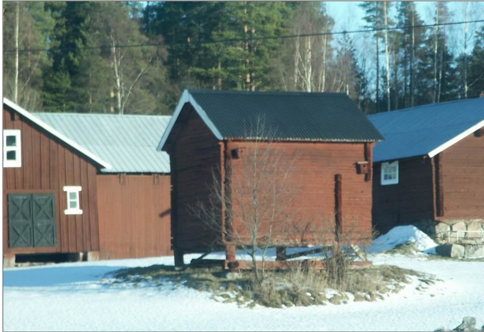
Figur 59. Exempel på en stolpburen förrådsbyggnad från en gårdsmiljö i Överhogdal i Härjedalen. Ingången sker från en kraftig trappa. Foto: Dan Fagerlund, Upplandsmuseet.
