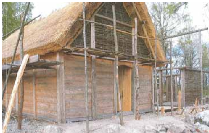
Figur 71. Rekonstruktioner av ett skiftesverkshus respektive ett flätverkshus från Birka, under uppförande. på Björkö (efter Rosberg 2009, omslag).
