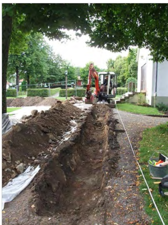
Figur 35. T.v Schaktet upp mot gravkapellet sett mot väster.
