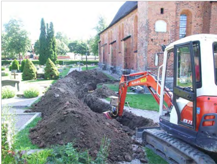
Figur 11. T.v. Schaktning för etapp 1. Foto mot Ö.
