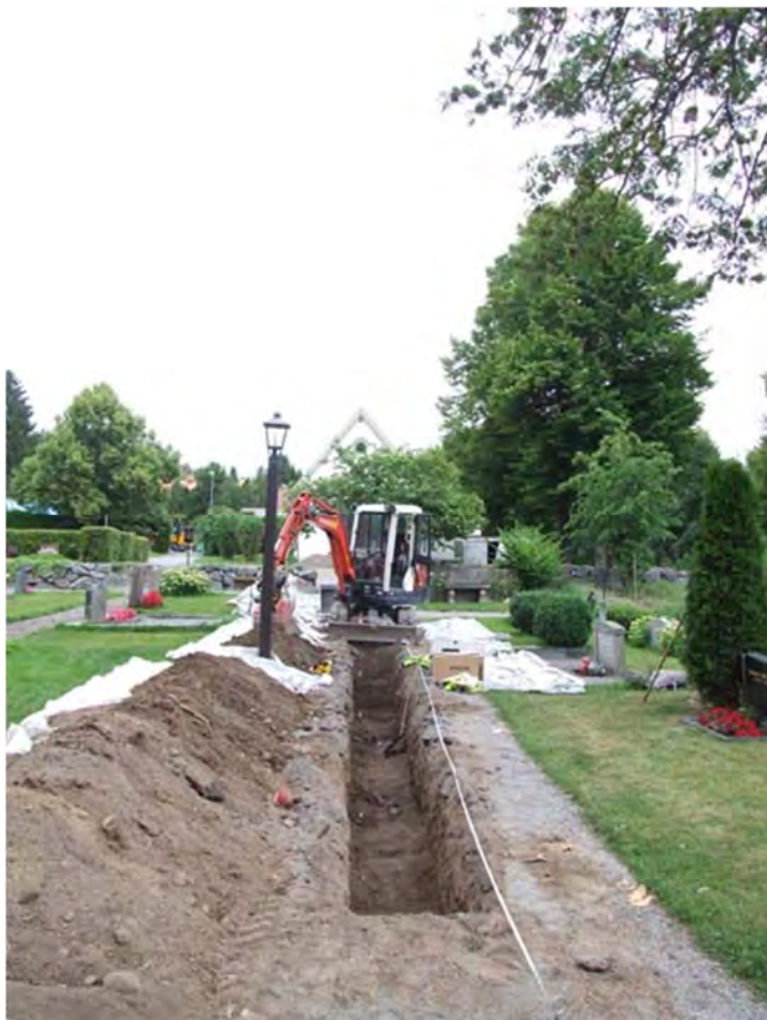
Figur 18. Översikt över etapp 2 från A6 och mot norr. Foto mot N.
