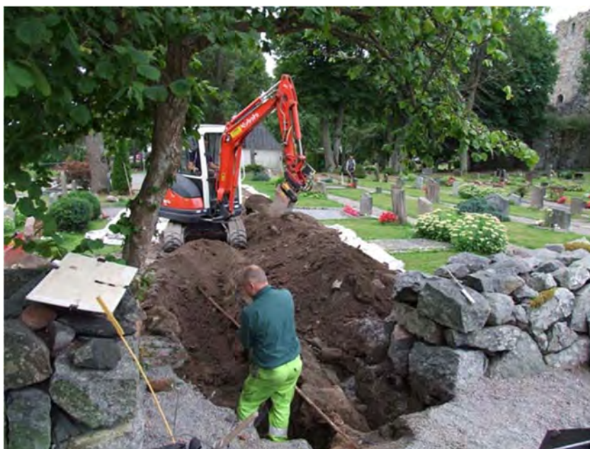
Figur 38. Schaktning vid öppning i bogårdsmur. Foto mot SV.
