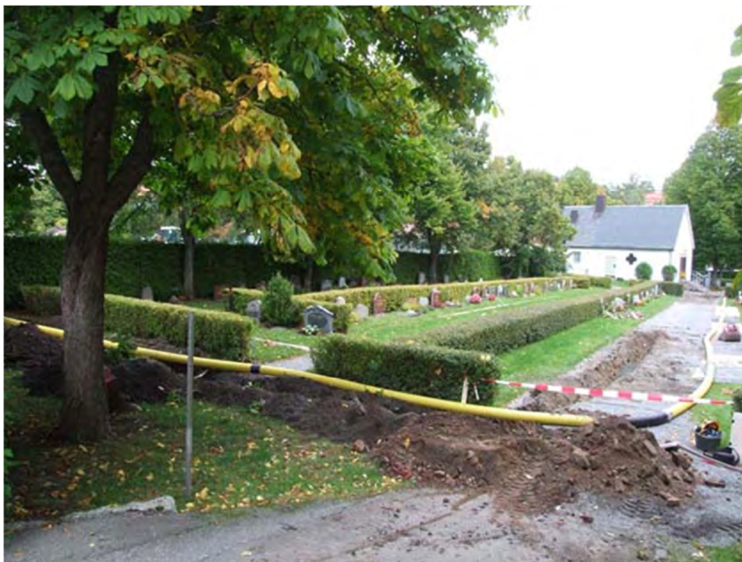
Figur 41. Schakt för ny eldragning på kyrkogårdens nordvästra del vid gravkvarter 10. Foto mot NO.
