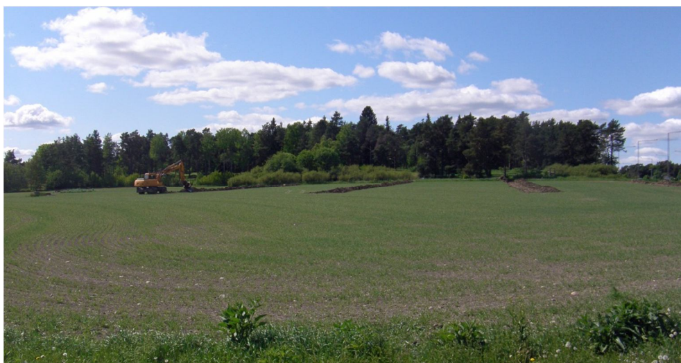
Figur 28. Foto från schaktning på yta B vid Starbo. Skärvstenshögen Raä Uppsala 317:1 ligger inne bland träden. Åkerområdets plåtåliknande övre del syns tydligt. Foto fr O: Dan Fagerlund, Upplandsmuseet.
